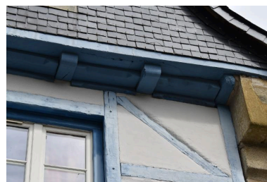
Détail des sablières d'encorbellement et des solives Phot. Rémy Paurion
