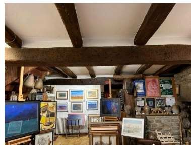
Détail des poutres et solives intérieures Phot. Tabet Sylvie IVR53_20245610207NUCA
