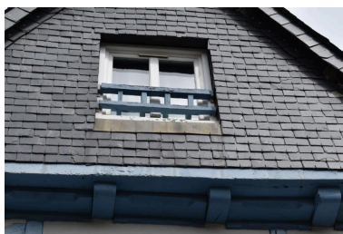
Détail de l'essentage d'ardoises Phot. Rémy Paurion IVR53_20245610178NUCA
