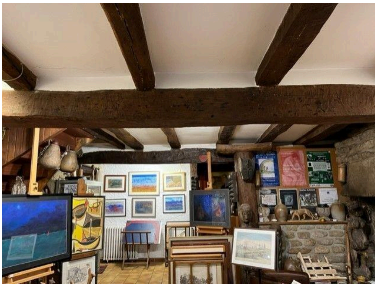
Détail des poutres et solives intérieures
