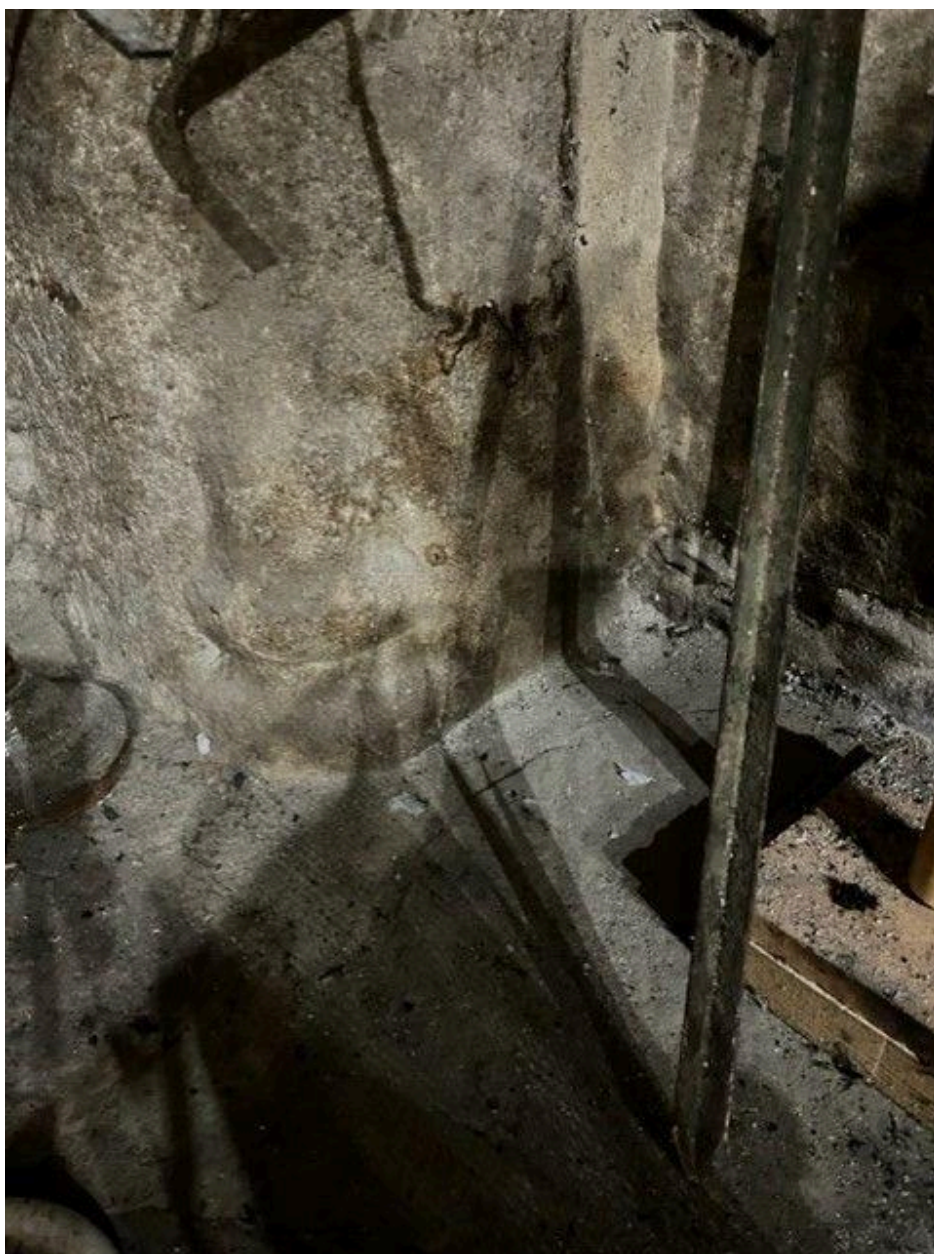
Détail du talon du jambage de la cheminée
