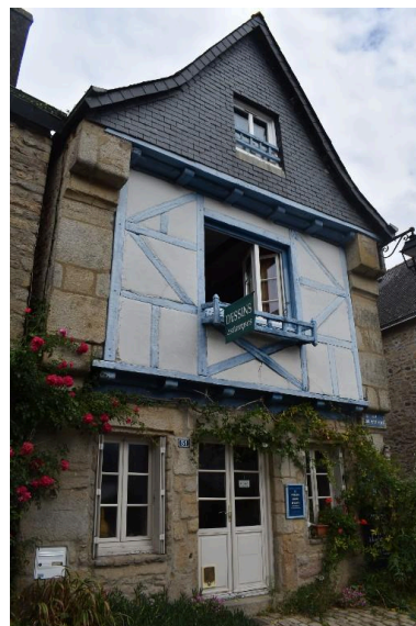
Façade à pan de bois avec encorbellement sur solives Phot. Rémy Paurion IVR53_20245610183NUCA
