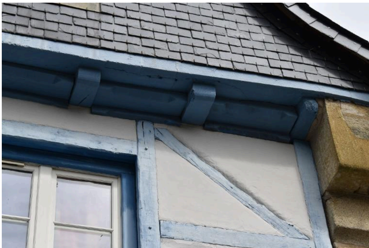
Détail des sablières d'encorbellement et des solives
