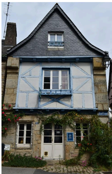
Façade à pan de bois avec encorbellement sur solives Phot. Rémy Paurion IVR53_20245610182NUCA
