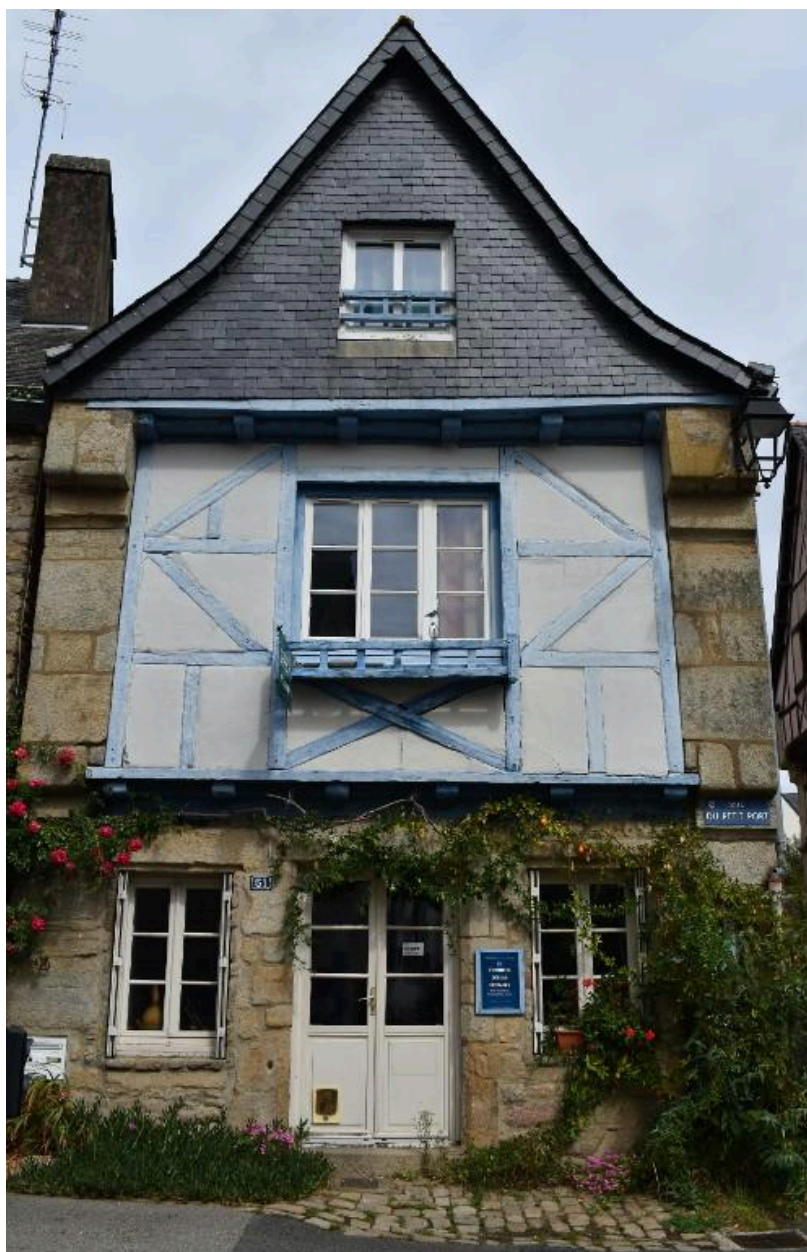
Façade à pan de bois avec encorbellement sur solives
