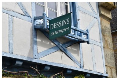
Détail de l'enseigne Phot. Rémy Paurion IVR53_20245610180NUCA
