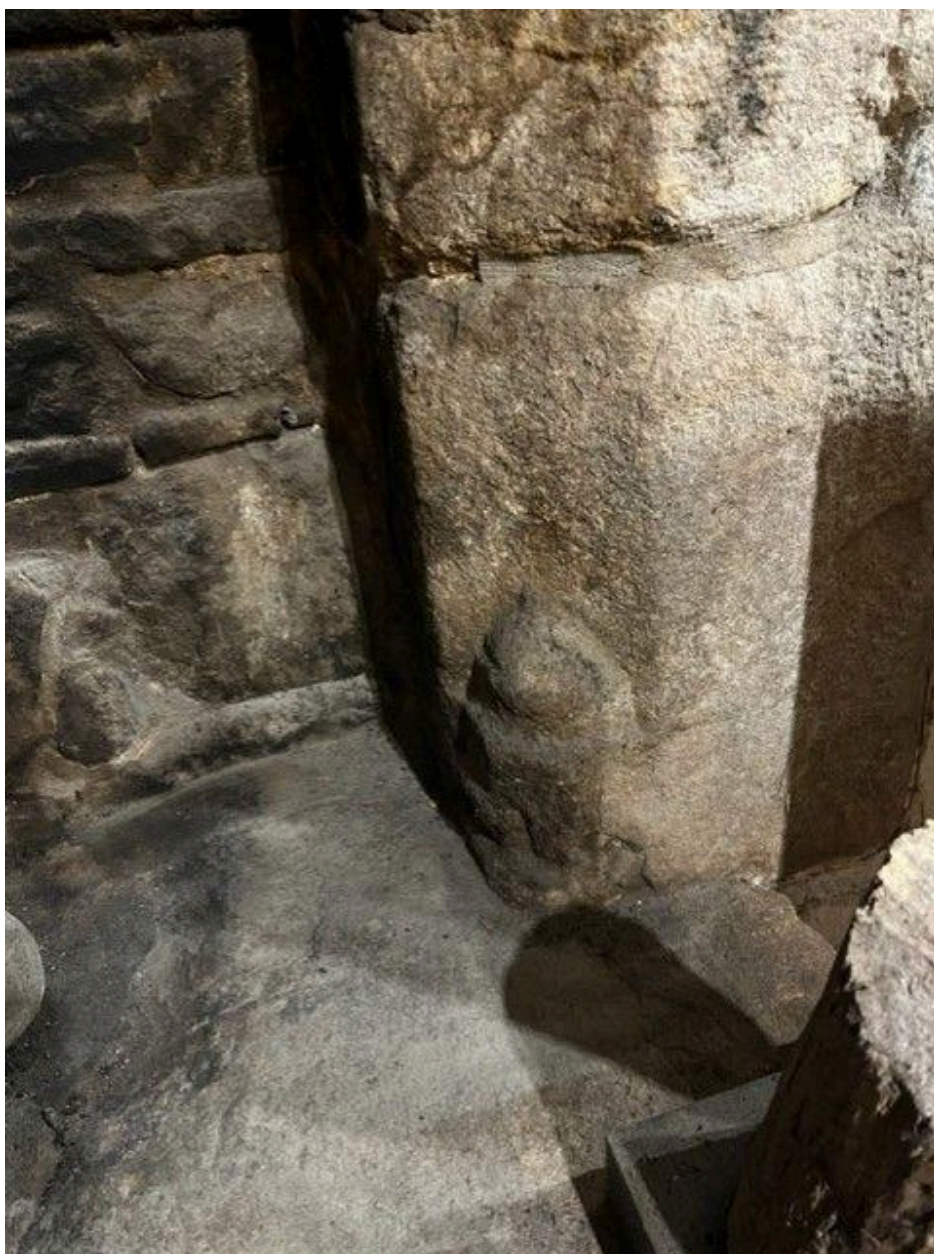
Détail du talon de la cheminée
