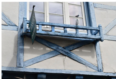
Détail d'une croix de Saint-André Phot. Rémy Paurion IVR53_20245610179NUCA
