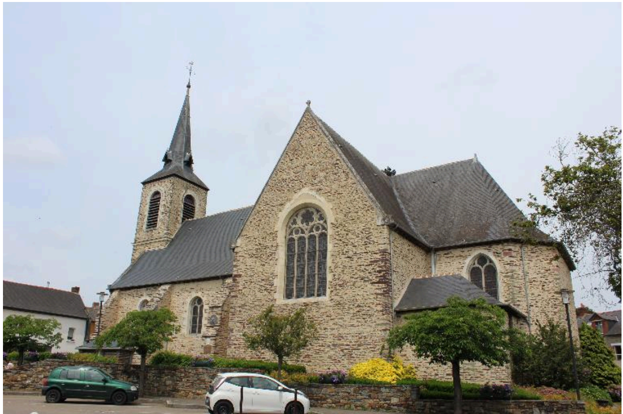
Vue générale, façade nord.
