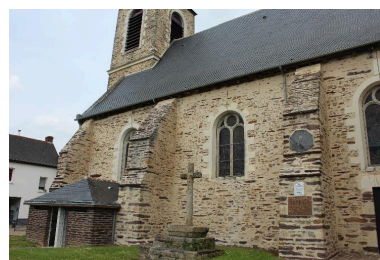
Détails façade nord. Phot. Déborah De Sousa Figueiredo IVR53_20163505570NUCA
