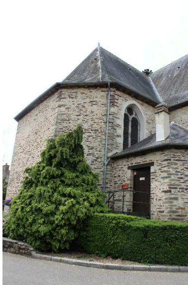
Façade nord du chevet. Phot. Déborah De Sousa Figueiredo IVR53_20163505569NUCA
