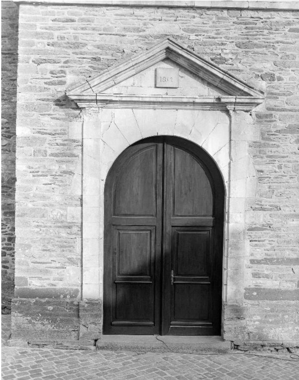
Elévation Ouest, porte : vue générale (Etat en 1994)
