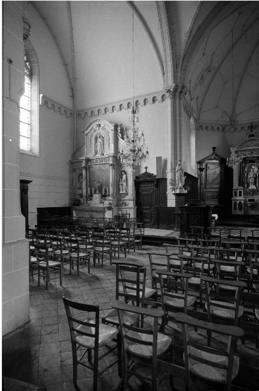
Intérieur : vue générale du bras nord du transept, vue prise du sud-ouest (Etat en 1968)
