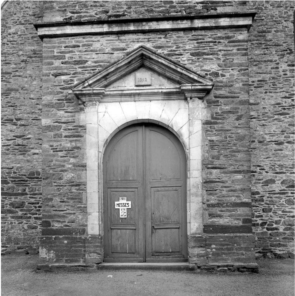
Elévation Ouest, porte : vue générale (Etat en 1968)
