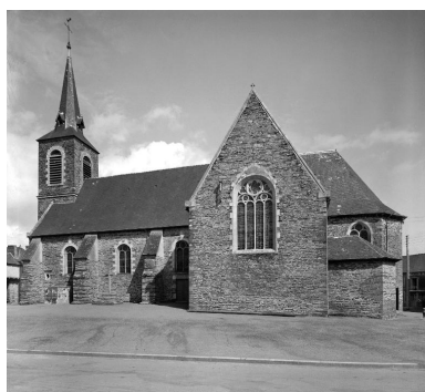
Elévation sud : vue générale (Etat en 1968) Phot. François Dagorn IVR53_19683500275V
