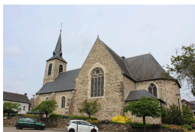
Vue générale, façade nord. Phot. Déborah De Sousa Figueiredo IVR53_20163505568NUCA
