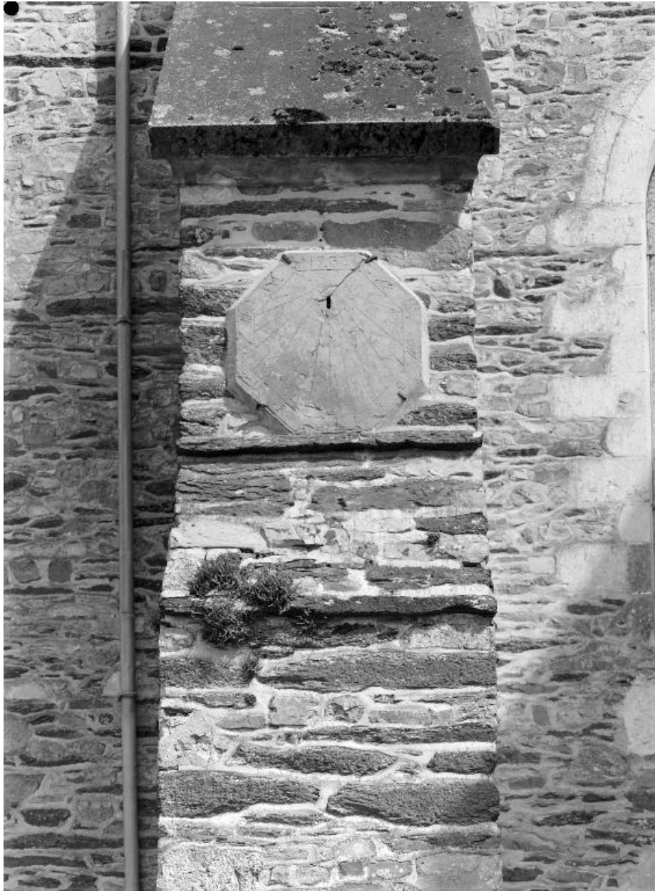
Cadran solaire, vue générale (Etat en 1968)
