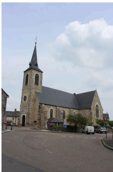
Vue générale sud-ouest. Phot. Déborah De Sousa Figueiredo IVR53_20163505639NUCA
