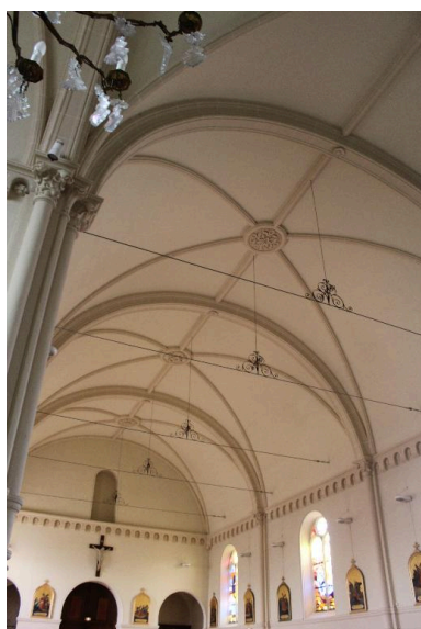
Vue générale nef. Phot. Déborah De Sousa Figueiredo IVR53_20163505571NUCA
