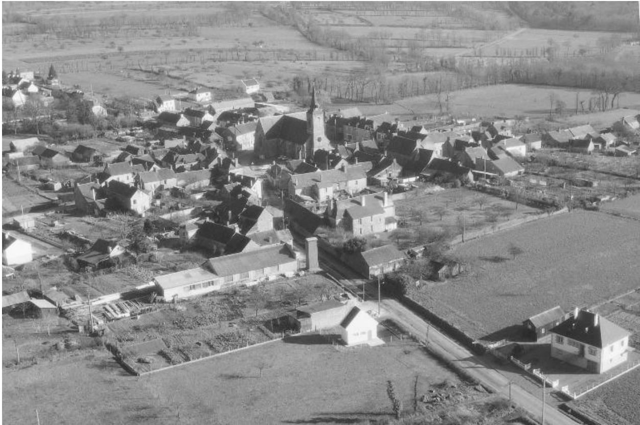
Vue aérienne vers l'est (Etat en 1971)
