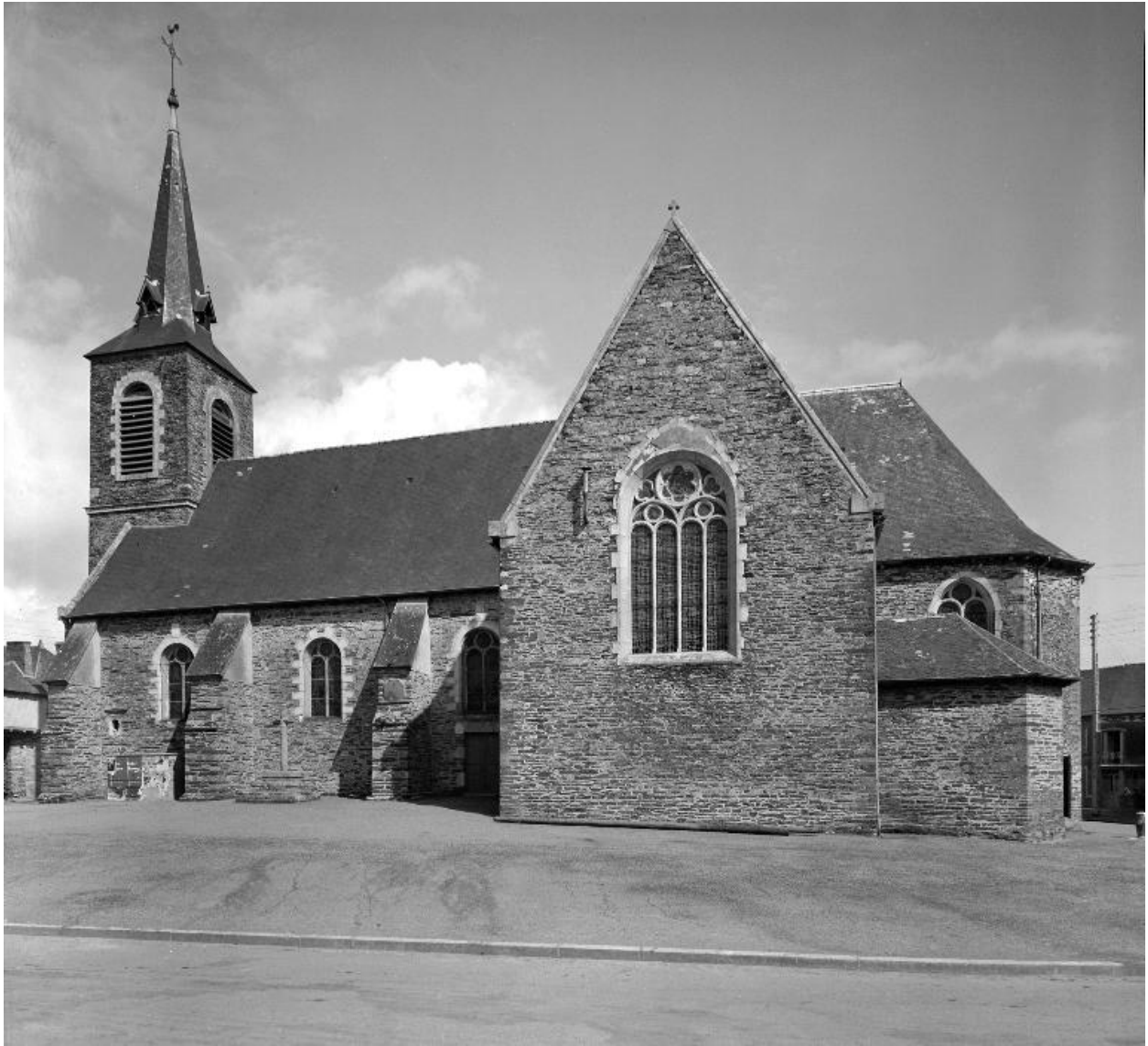
Elévation sud : vue générale (Etat en 1968)
