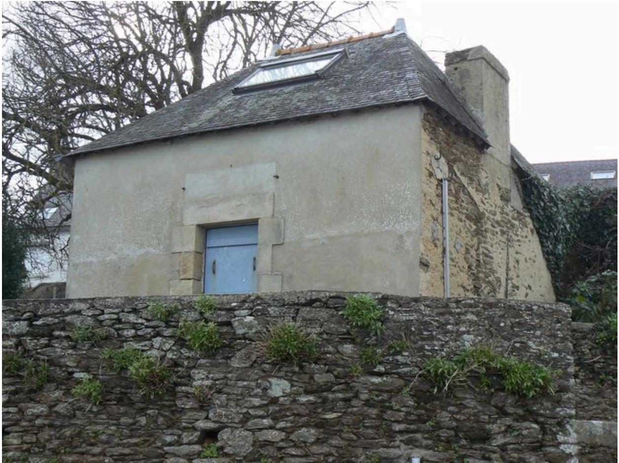
Corps de garde aval vu du quai
