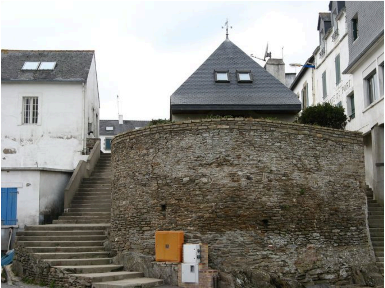
Corps de garde amont vu du quai
