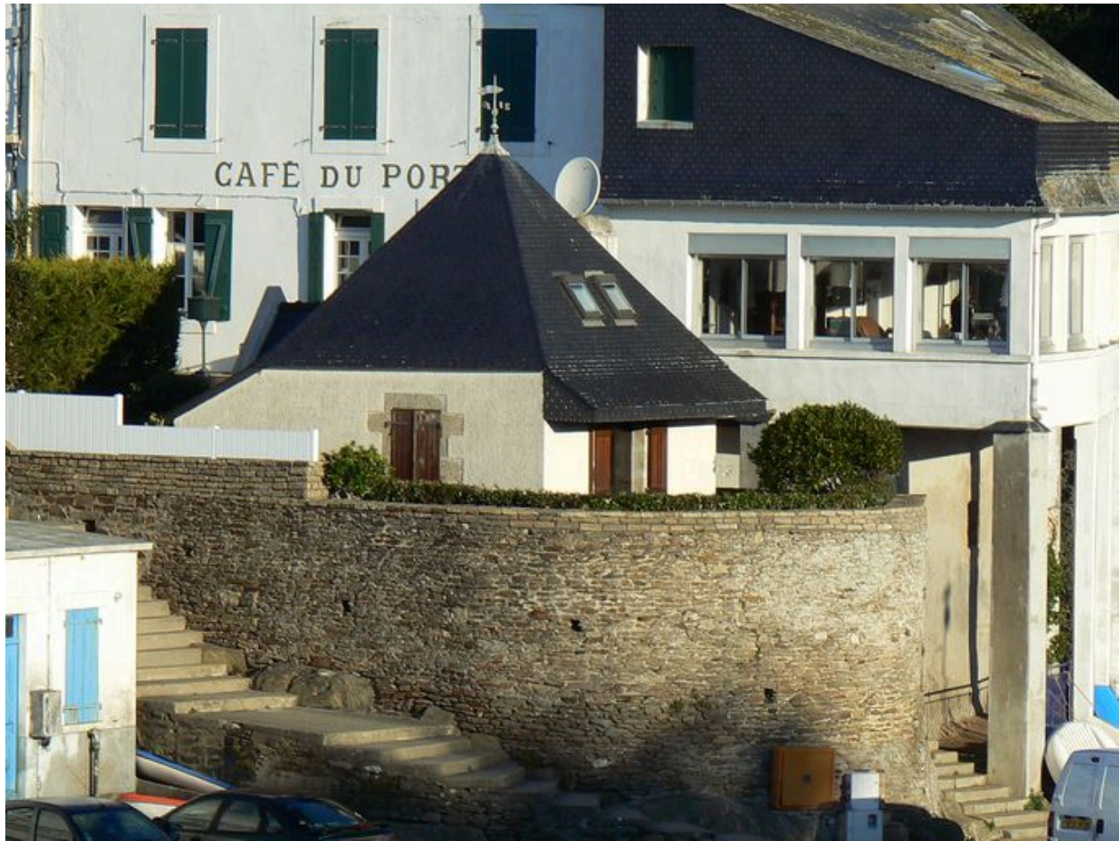
Corps de garde amont
