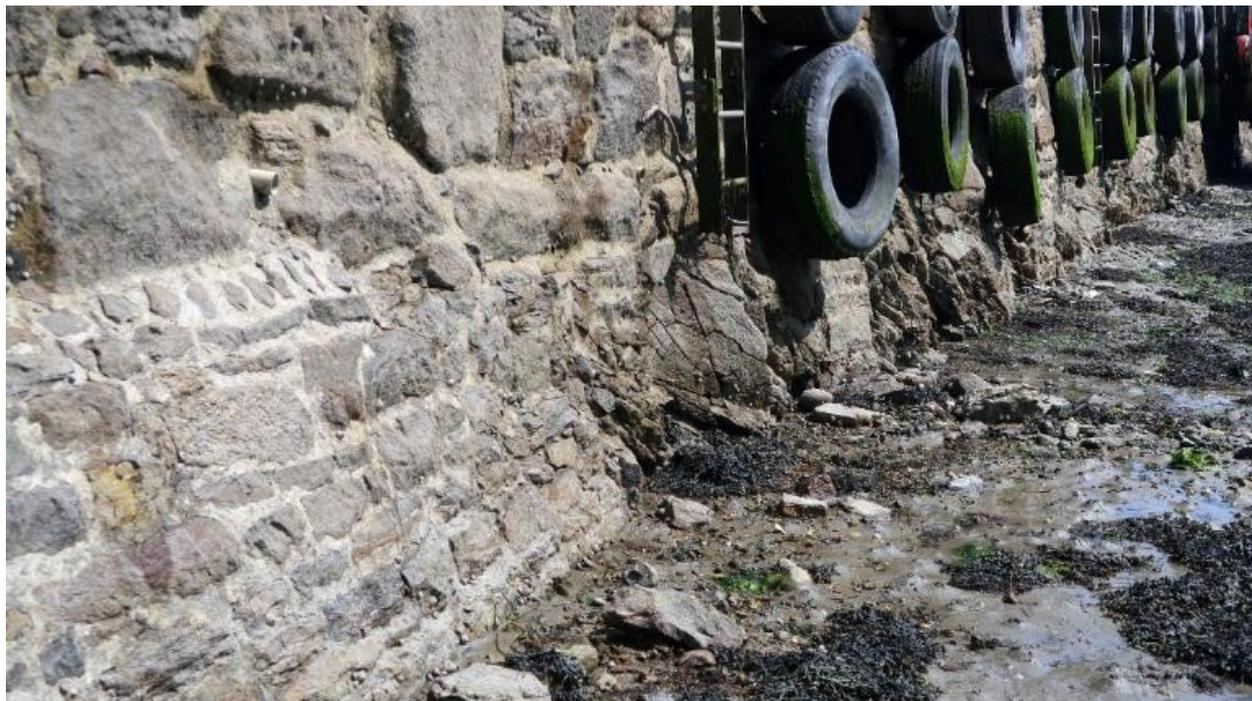
Le vieux quai du port fondé sur rocher : maçonnerie du mur de soutènement sud
