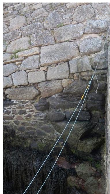
Maçonnerie du vieux quai, côté Nord : moellons de différentes tailles et d'origine géologique diverse. Joints par pierres de petite taille.
