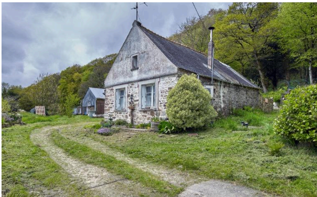
Maison construite en lisière de bois. Pignon est avec fenêtres créées dans les années 1930. Vue générale nord-est
