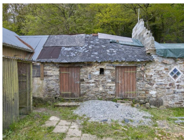
Soue à cochons en retour de la maison, 19e siècle. Vue générale est Phot. Bègne Bernard IVR53_20242200316NUCA
