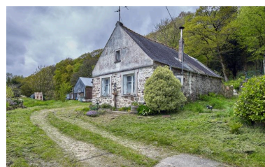
Maison construite en lisière de bois. Pignon est avec fenêtres créées dans les années 1930. Vue générale nord-est Phot. Bègne Bernard IVR53_20242200314NUCA
