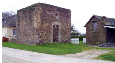
Vue générale nord-ouest Phot. Xavier Gilbert IVR53_19993504740NUCA
