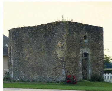
Vue générale nord-ouest Phot. Guy Artur, Phot. Norbert Lambart IVR53_19993501227XA
