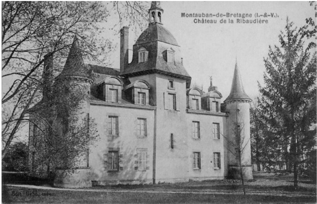
Vue générale de la façade postérieure
