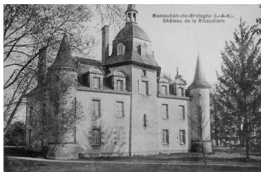
Vue générale de la façade postérieure Phot. Auteur inconnu IVR53_19883500407XB
