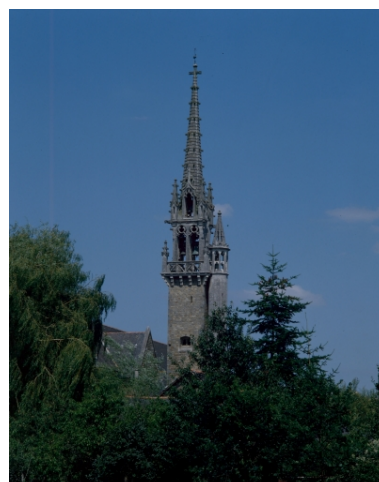
Elévation sud, clocher : vue générale Phot. Guy Artur, Phot. Norbert Lambart IVR53_19923500685XA
