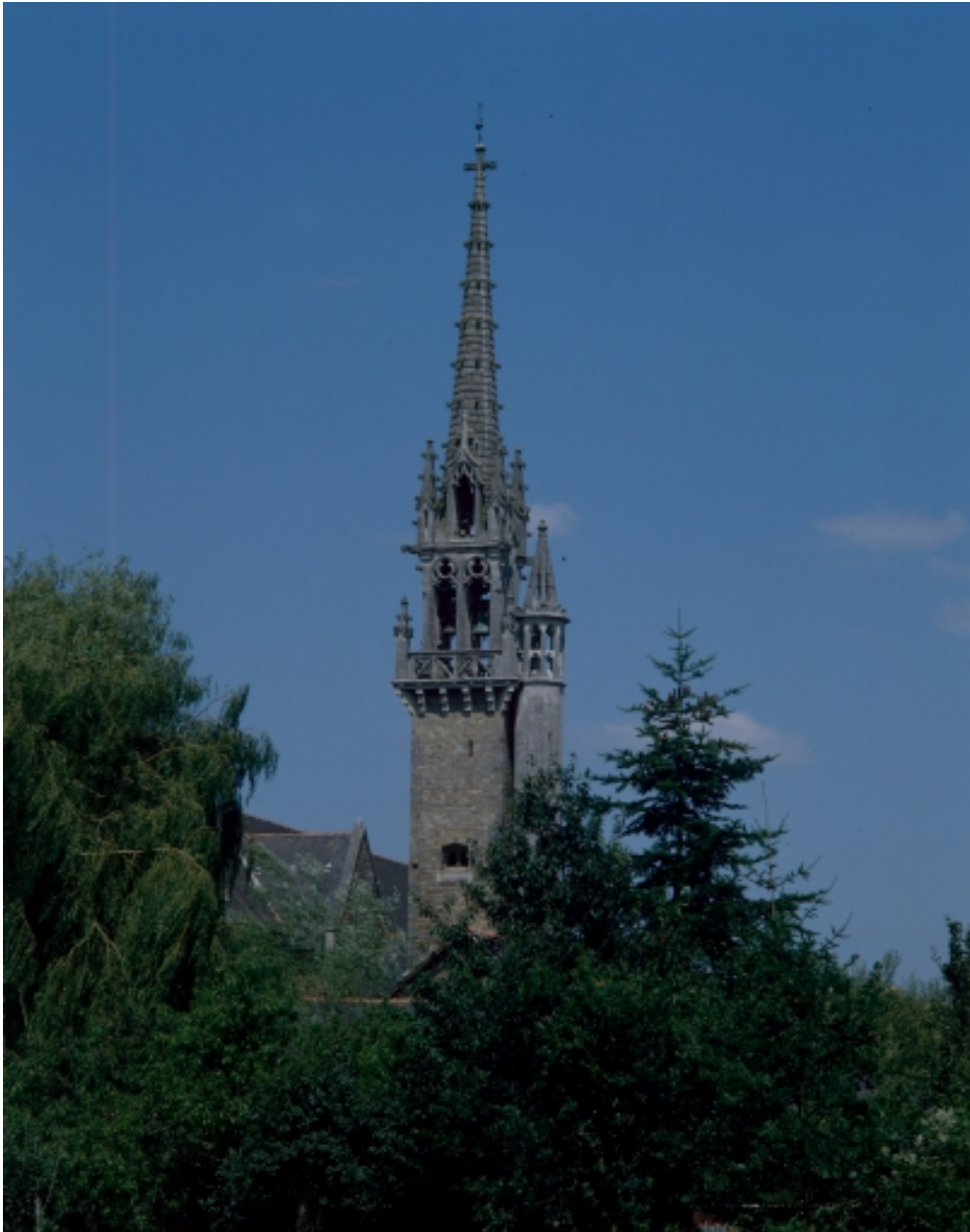
Elévation sud, clocher : vue générale
