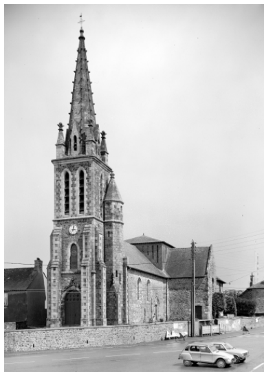
Elévation sud-ouest : vue générale Phot. L. Lamandé IVR53_19863500553V
