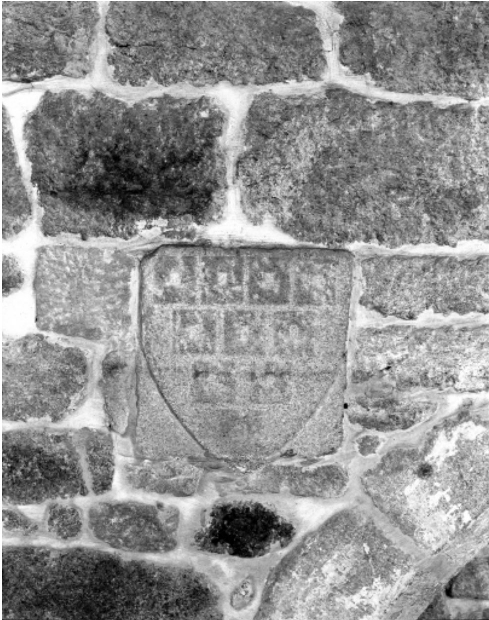
Mur de la nef, écu : vue générale
