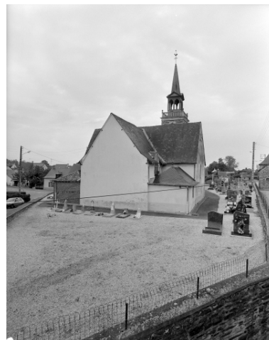
Elévation est : vue générale. Phot. Guy Artur, Phot. Norbert Lambart IVR53_19943500914X
