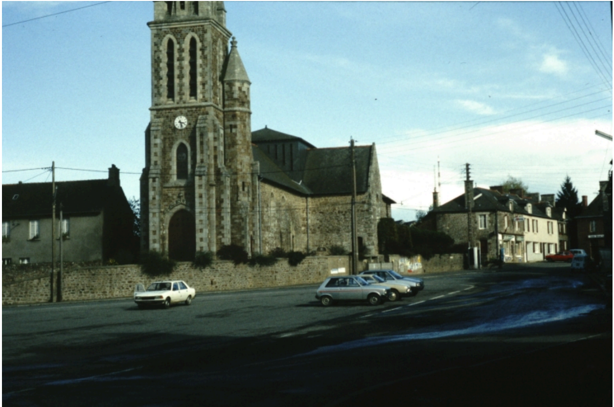
Vue générale prise de l'ouest
