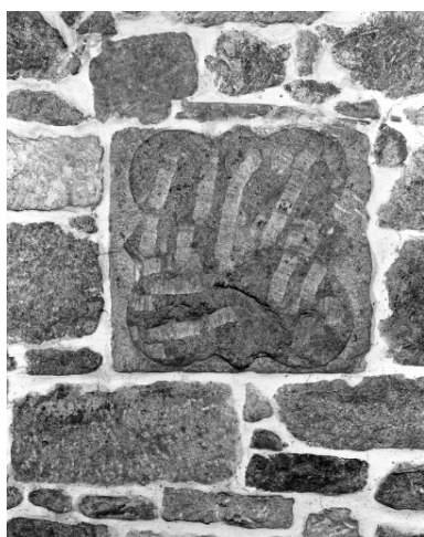
Mur de la nef, écu martelé : vue générale Phot. L. Lamandé IVR53_19853501161X
