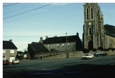
Vue générale Phot. Denise Dufief, Repro. Norbert Lambart IVR53_19853500756ZA
