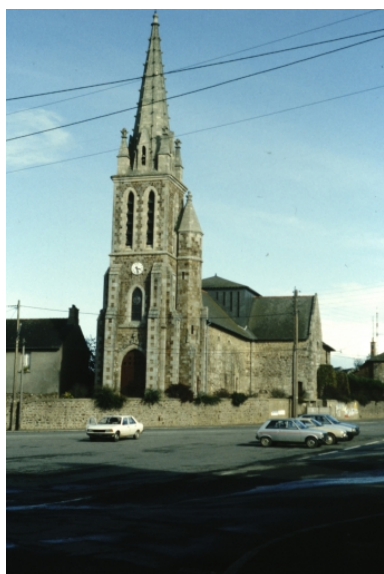
Vue générale Phot. Denise Dufief, Repro. Norbert Lambart IVR53_19853500757ZA
