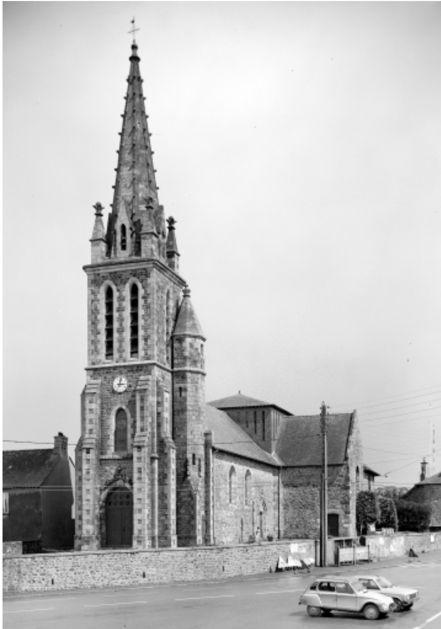
Elévation sud-ouest : vue générale
