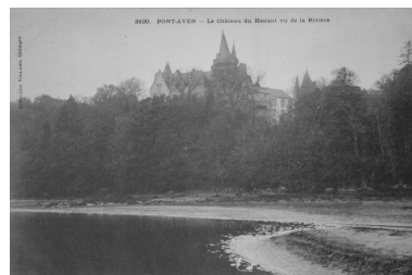
Vue depuis la rivière Phot. Elise Lauranceau IVR53_20052904387NUCB
