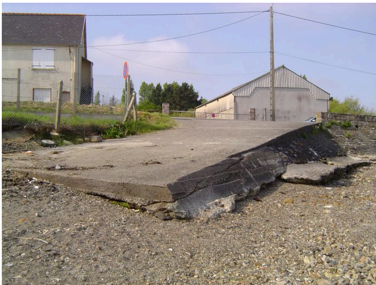
Cale de l'extrémité méridionale de la digue-route
