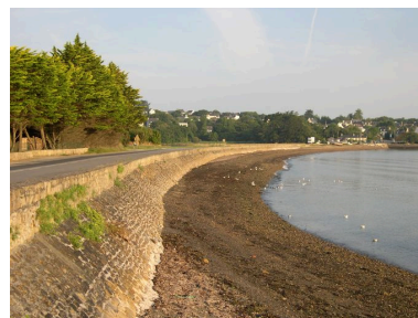
Détail de la digue-route du Sillon Phot. Clotilde Buhot IVR53_20062908604NUCA
