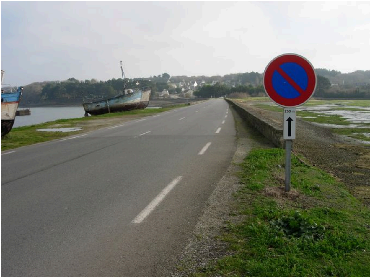
Vue générale de la digue-route du Sillon
