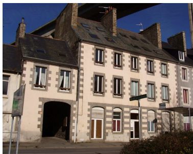
Vue générale, élévation principale Phot. Patrick Pichouron IVR53_20082212645NUCA
