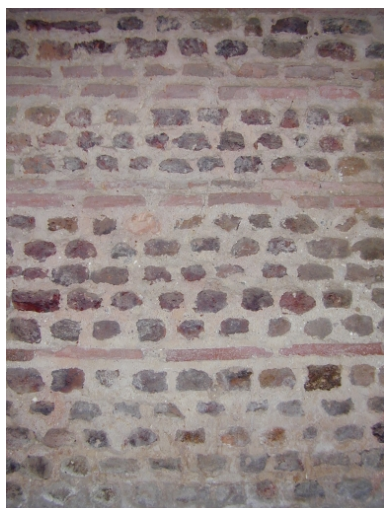
Vue intérieure, détail, appareillage du mur sud Phot. Elise Lauranceau IVR53_20013510120NUCA
