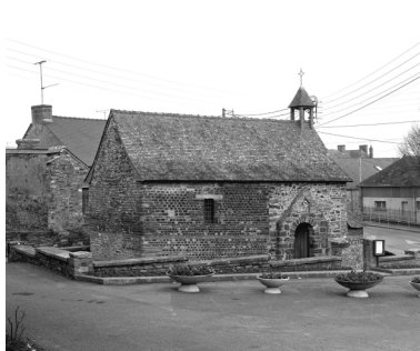
Vue générale sud-ouest Phot. Guy Artur, Phot. Norbert Lambart IVR53_19933500092X
