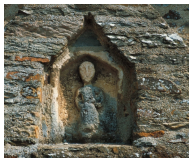
Façade sud : détail de la niche du portail sud Phot. Guy Artur, Phot. Norbert Lambart IVR53_20013501809XA
