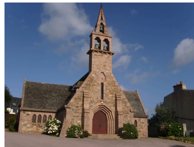
Vue générale Phot. Patrick Pichouron IVR53_20072210055NUCA
