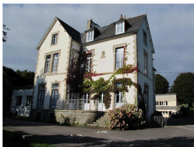
Toul ar c'hoat, façade sud Phot. Philippe Bonnet IVR53_20142905377NUCA
