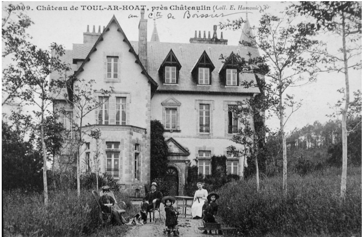
Vue générale de la façade principale (Archives départementales d'Ille-et-Vilaine, 6 Fi CHATEAULIN 27)
