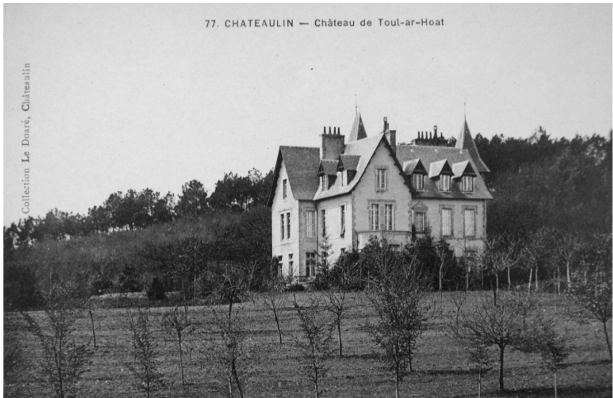
Vue de situation (Archives départementales d'Ille-et-Vilaine, 6 Fi CHATEAULIN 29)
