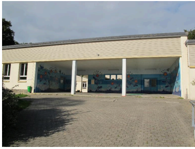
Toul ar c'hoat, bâtiment à usage de formation Phot. Philippe Bonnet IVR53_20142905382NUCA
