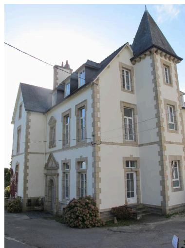
Toul ar c'hoat, façade nord et pignon ouest Phot. Philippe Bonnet IVR53_20142905379NUCA
