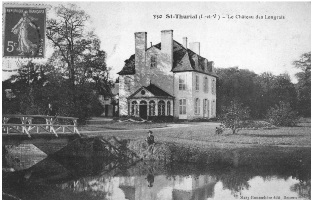
Vue générale au début du 20e siècle
