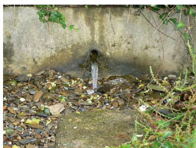
Vue générale de la fontaine de Pont-Scorff Phot. Lénaïg L'Aot IVR53_20072908940NUCA
