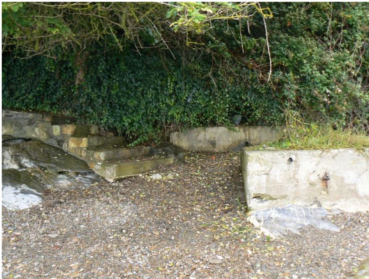
Escalier menant à la fontaine de Pont-Scorff
