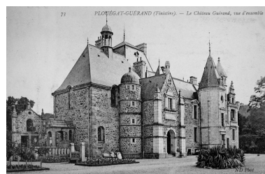
Vue rapprochée sur la façade principale du côté de la chapelle Phot. Elise Lauranceau IVR53_20042905553NUCB
