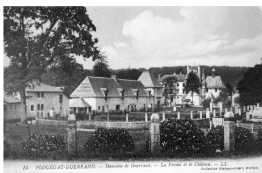
Vue de situation sur la façade postérieure et les parties agricoles Phot. Elise Lauranceau IVR53_20042905569NUCB
