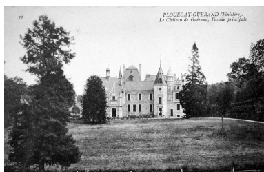
Vue de situation sur la façade principale Phot. Elise Lauranceau IVR53_20042905555NUCB
