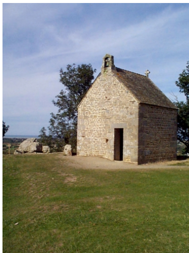
Vue générale sud Phot. Claude Quillivic IVR53_19973503313NUCA
