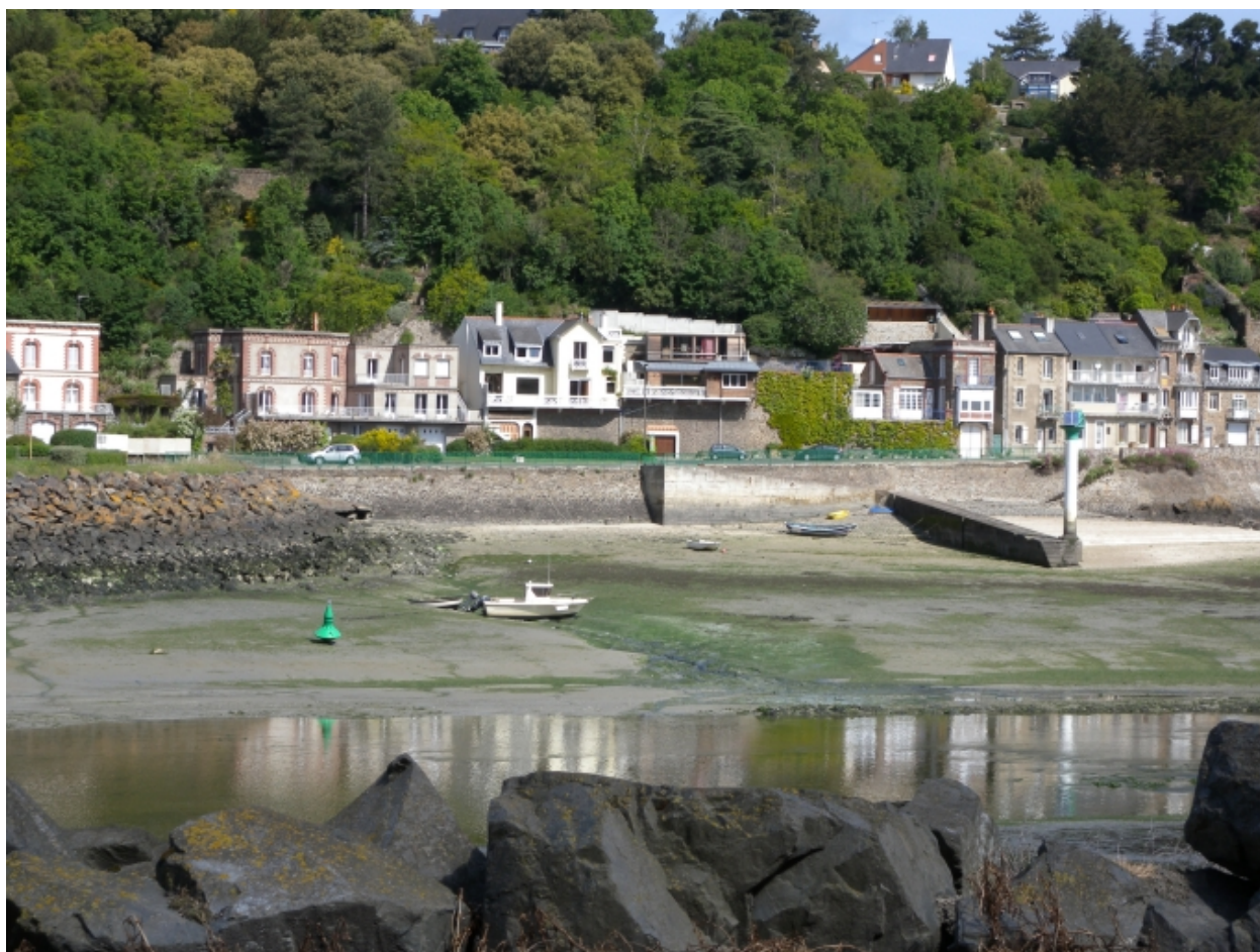
Vue de la cale de la Douane et des anciens murs de quais dans le prolongement du terre-plein de la Ville-Gilette
