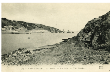
Vue en 1920 de l'ancienne cale, aujourd'hui détruite, à l'usage des marins-pêcheurs de Cesson (carte postale, AD 22) Phot. Auteur inconnu IVR53_20082213044NUCB
