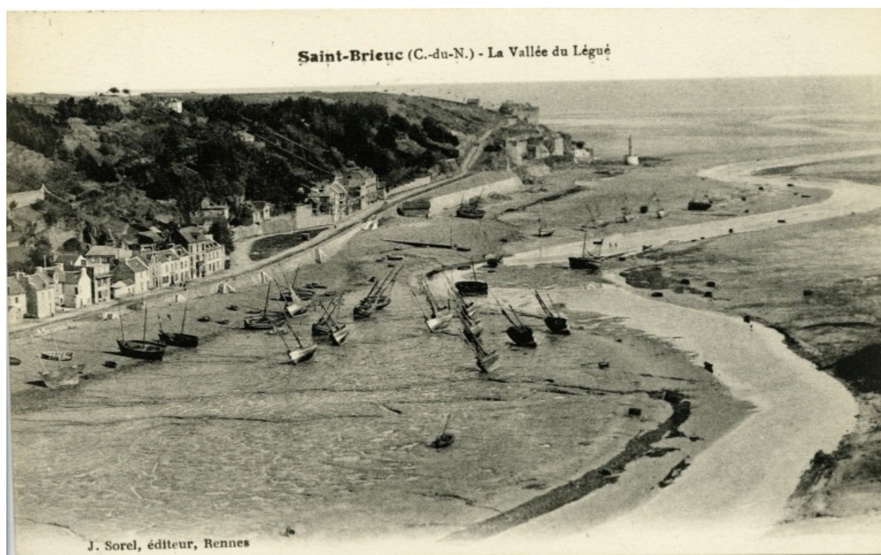
Vue du havre d'échouage de l'avant-port, vers 1910 : remarquer les murs de quais, rice gauche, équipés d'escaliers (AD 22)
