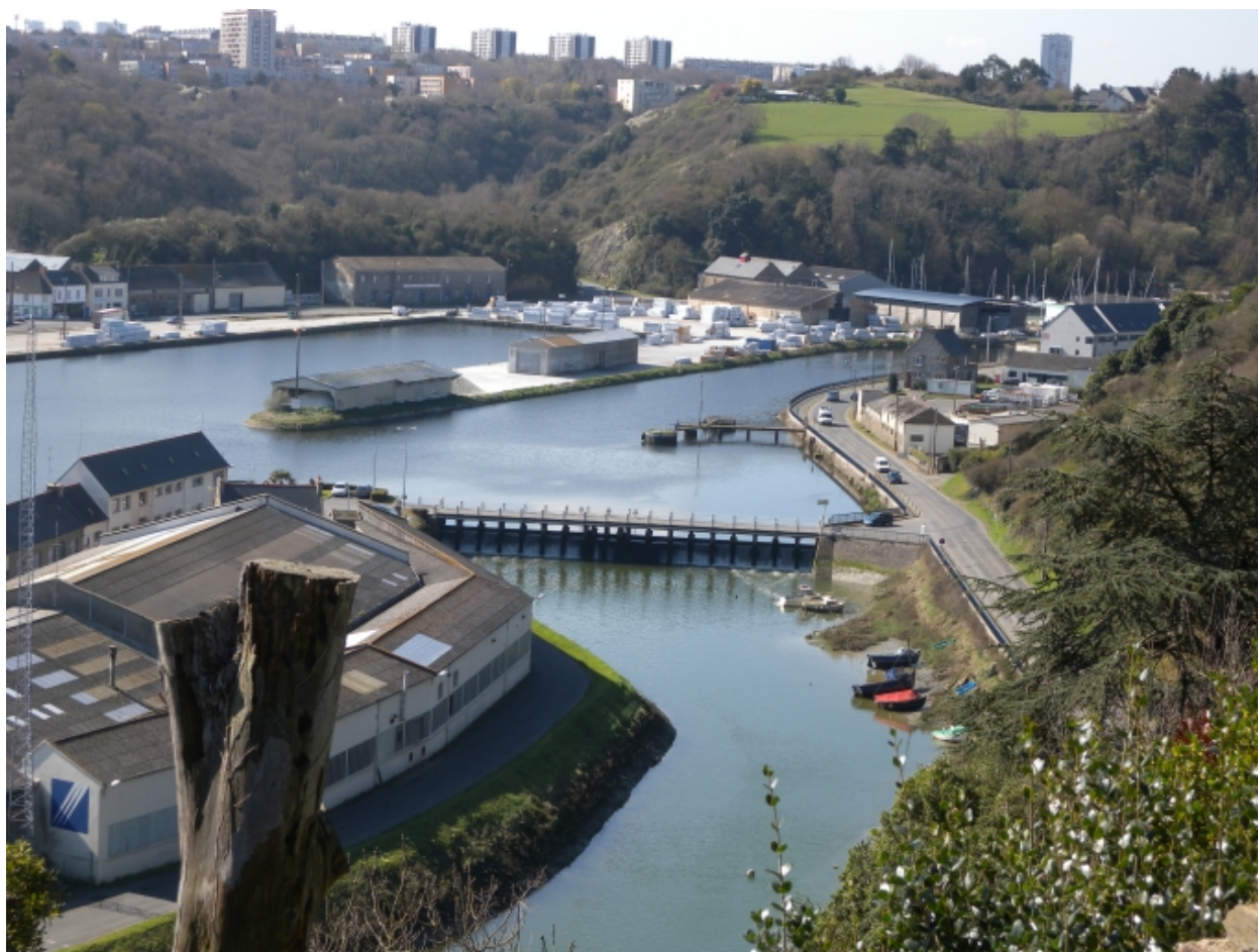
Vue générale de l'avant- port du Légué en amont : le barrage-déversoir, la 'Presqu'île' et le bassin n°1
