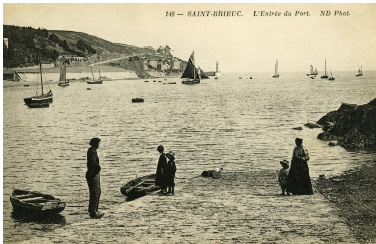
Vue de la cale des marins-pêcheurs de Cesson, en aval, rive droite, vers 1920 (AD 22)
