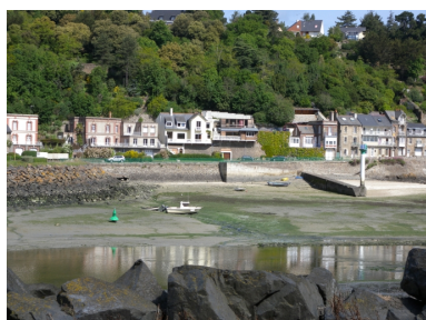
Vue de la cale de la Douane et des anciens murs de quais dans le prolongement du terre-plein de la Ville-Gillette Phot. Guy Prigent IVR53_20082212922NUCA
