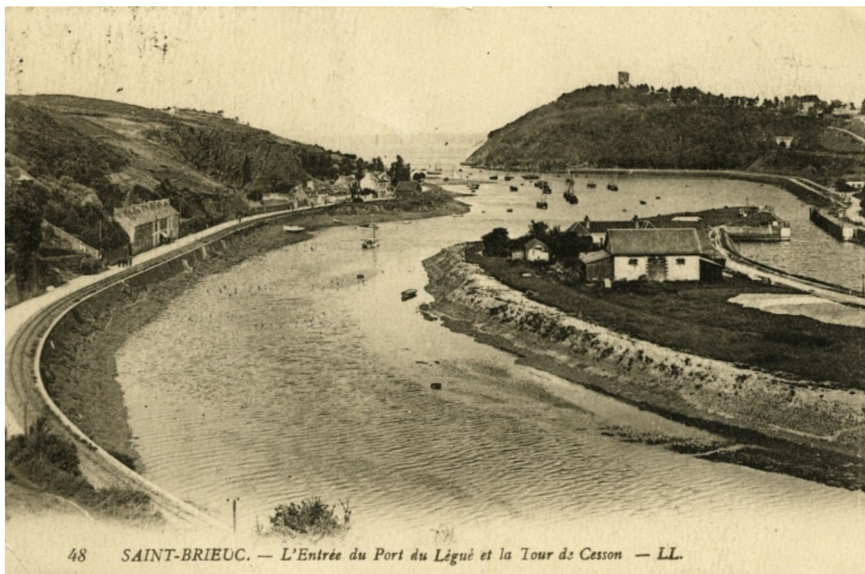
L'avant-port au niveau de la Presqu'île (encore appelée 'L'île Sèche'), l'écluse, vers 1922 (AD 22)
