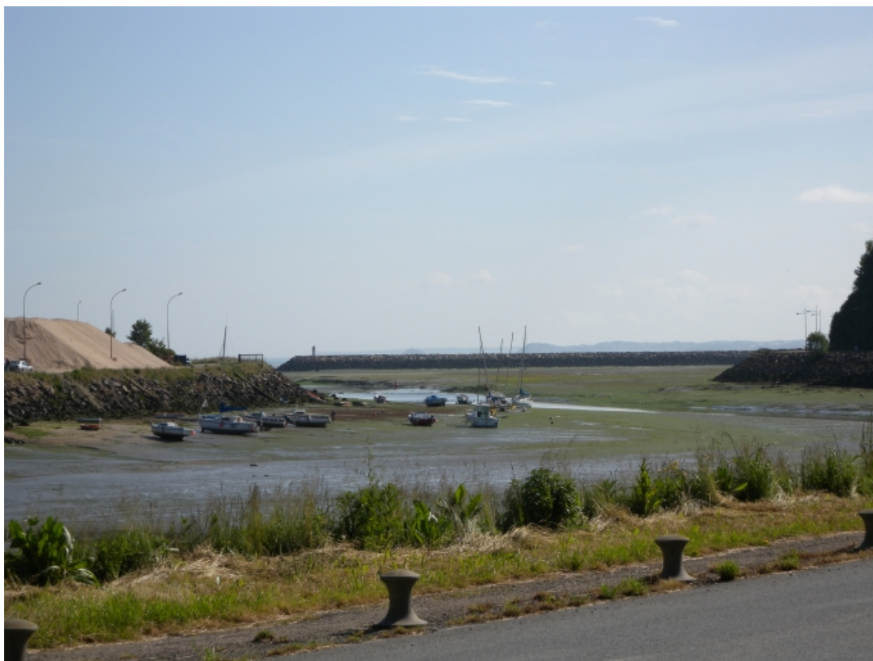
Vue en aval de l'avant-port et de l'extension rive droite
