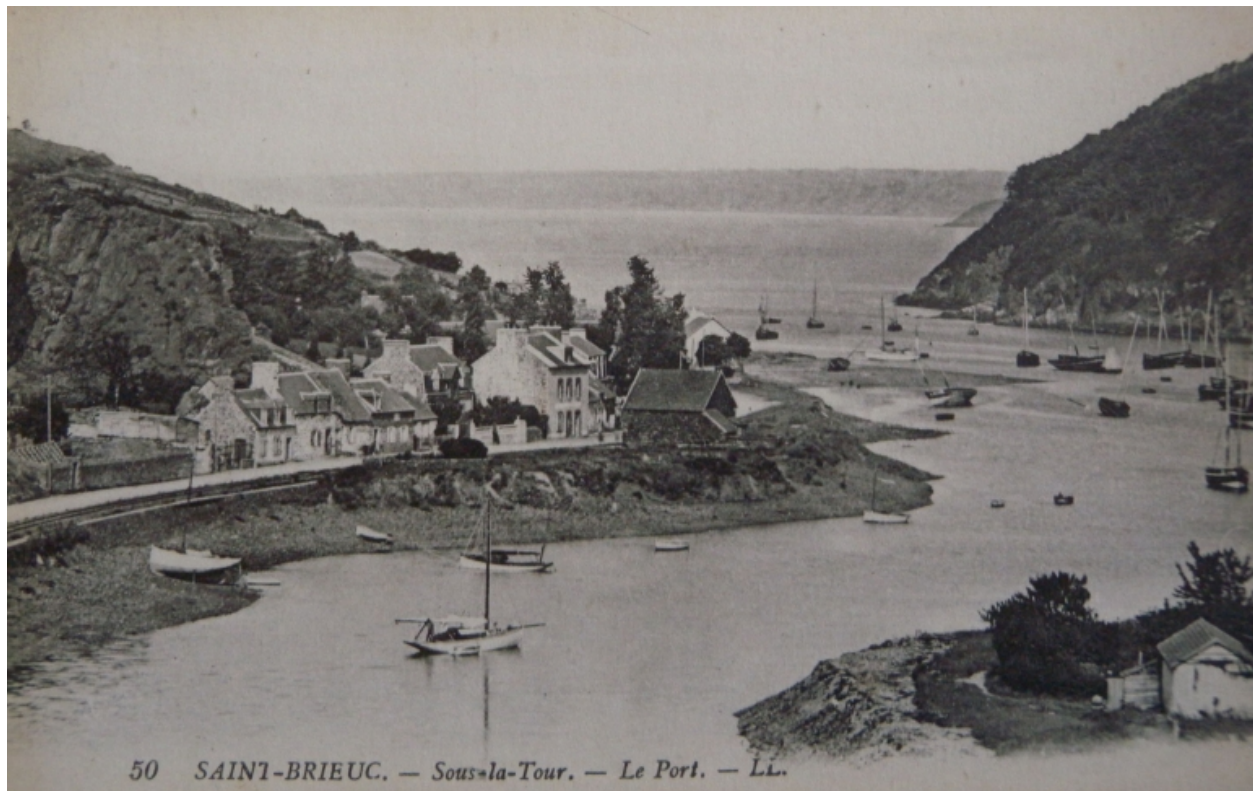
Vue de l'avant-port en aval de la Presqu'île, début 20ème siècle (collection particulière)
