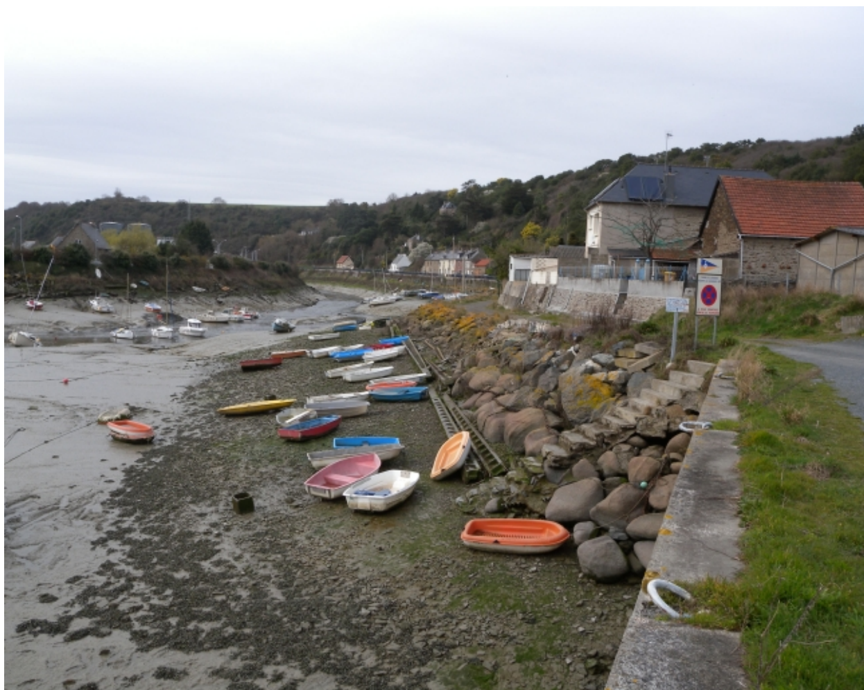
Vue des enrochements en bordure du chenal, avec les bateaux échoués
