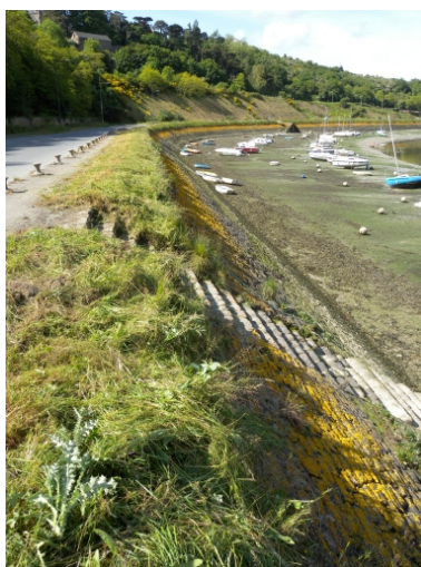
Vue des escaliers de desserte du mur de quai, rive droite Phot. Guy Prigent IVR53_20082212940NUCA
