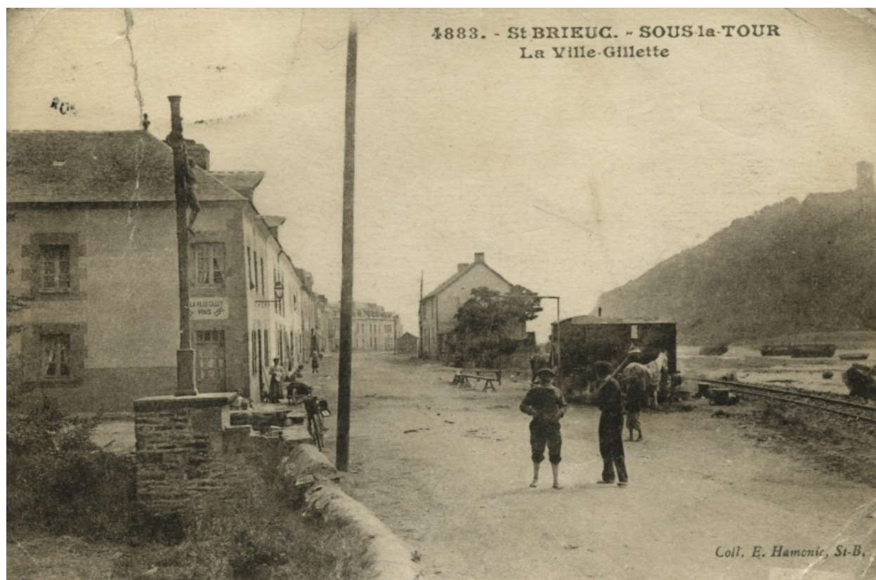
Vue du village de la Ville-Gillette, vers 1924 : remarquer la ligne de chemin de fer qui longe le chemin de halage (AD 22)
