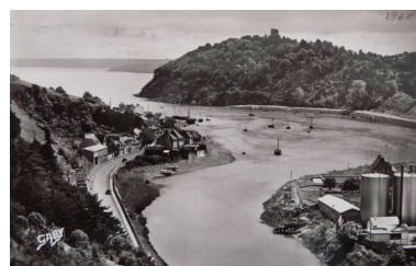
Vue de l'avant-port en aval de la Presqu'île, vers 1960 : remarquer l'usine à goudron de la DDE (collection particulière) Repro. Guy Prigent, Autr. Gaby IVR53_20082212929NUCB
