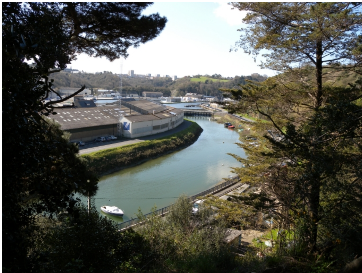
Vue du chenal de l'avant-port en aval du barrage-déversoir, à marée haute
