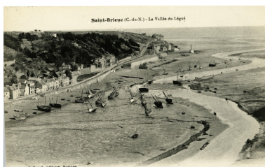
Vue du havre d'échouage de l'avant-port, vers 1910 : remarquer les murs de quais, rive gauche, équipés d'escaliers (AD 22) Phot. Editions J. Sorel, Autr. Editions J. Sorel IVR53_20082212932NUCB
