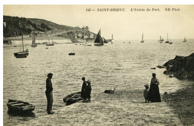
Vue de la cale des marins-pêcheurs de Cesson, en aval, rive droite, vers 1920 (AD 22) Phot. Nederlein, Autr. Nederlein IVR53_20082212935NUCB
