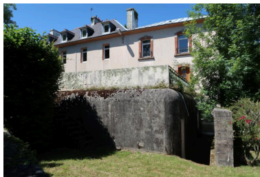
Vue générale depuis le sud-est (état en 2022) Phot. Guillaume Lécueillier IVR53_20222905481NUCA
