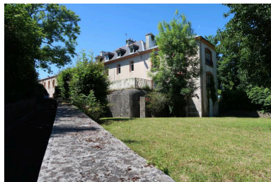
Vue de situation depuis le sud-est (état en 2022) Phot. Guillaume Lécueillier IVR53_20222905480NUCA
