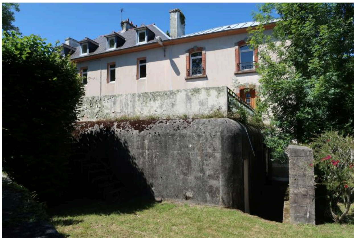
Vue générale depuis le sud-est (état en 2022)
