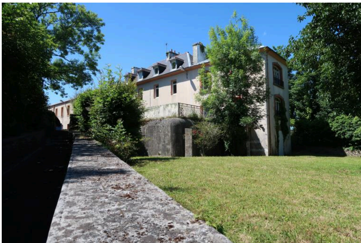
Vue de situation depuis le sud-est (état en 2022)
