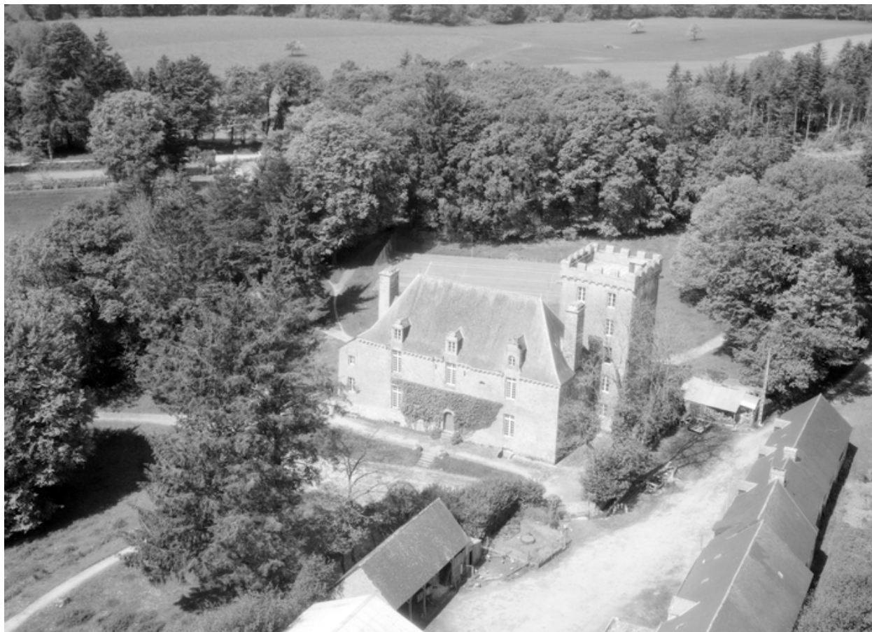
Vue aérienne prise du sud-est
