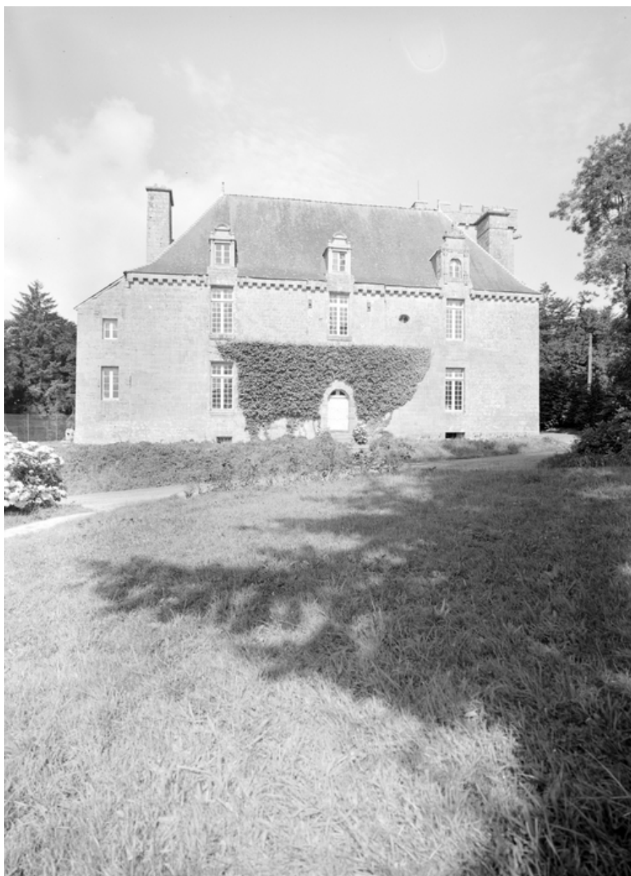
Façade sud, vue générale
