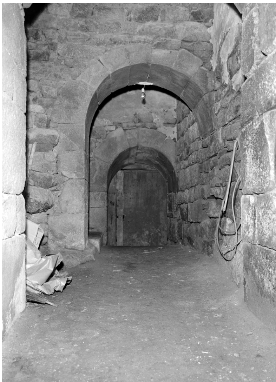
Voûte de l'entrée de la cave
