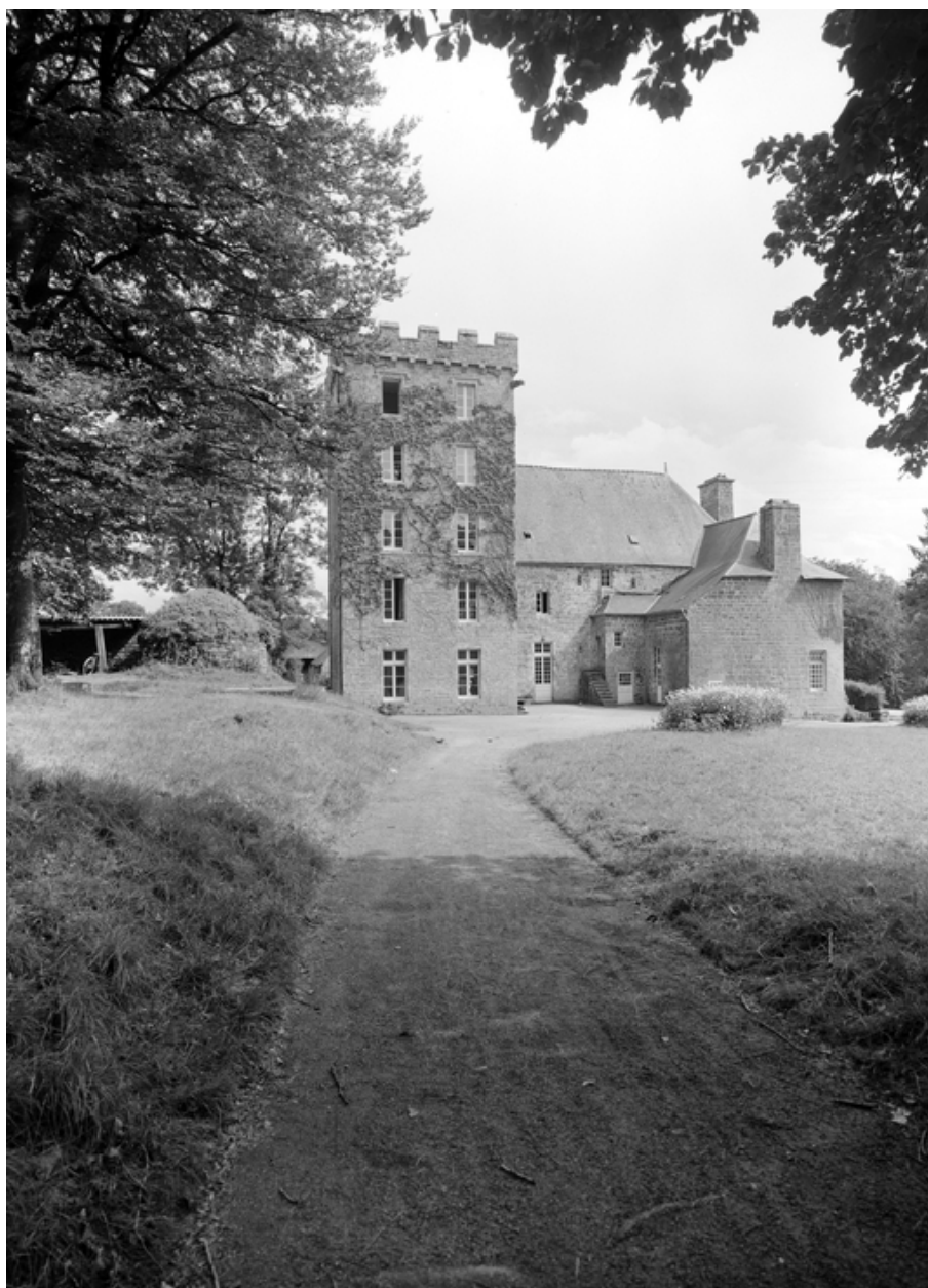
Façade nord, vue générale
