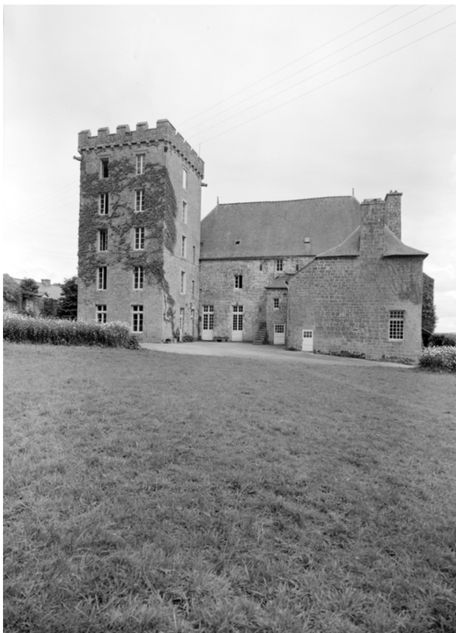
Façade nord, vue générale
