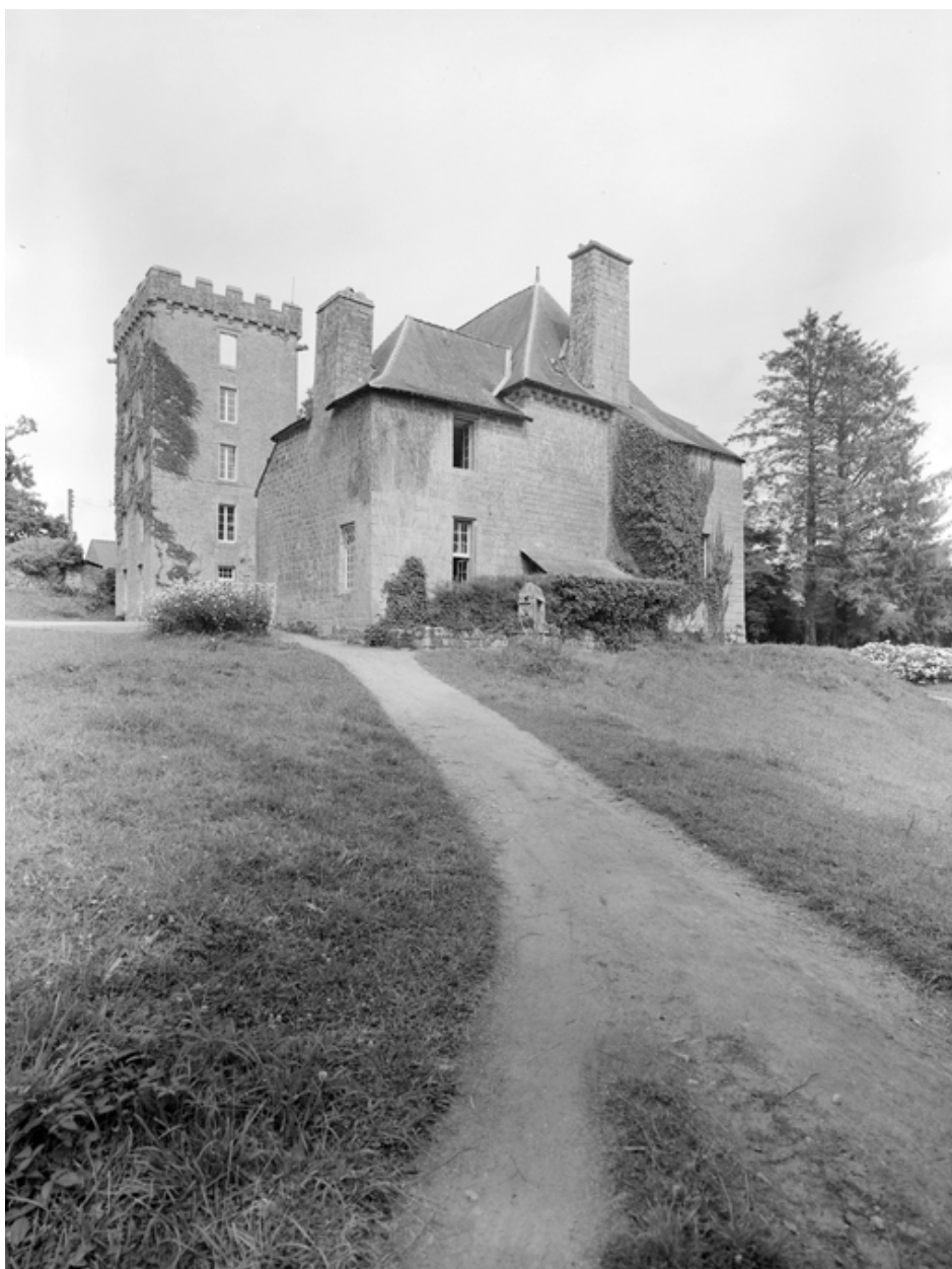
Vue prise du nord-ouest
