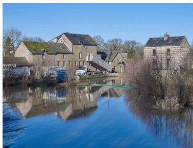
Vue du moulin/minoterie de Roudun par les voyageurs Phot. Bernard Bègne IVR53_20263500309NUCA
