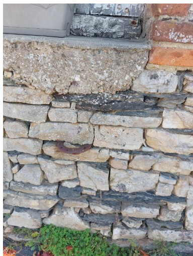
Fer à cheval incrusté dans le parement de la façade principale Phot. Cleo IVR53_20253532156NUCA
