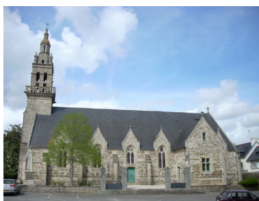
Landeleau, église paroissiale Saint-Théleau : élévation sud Phot. Gwénaél Fauchille IVR53_20082905560NUCA
