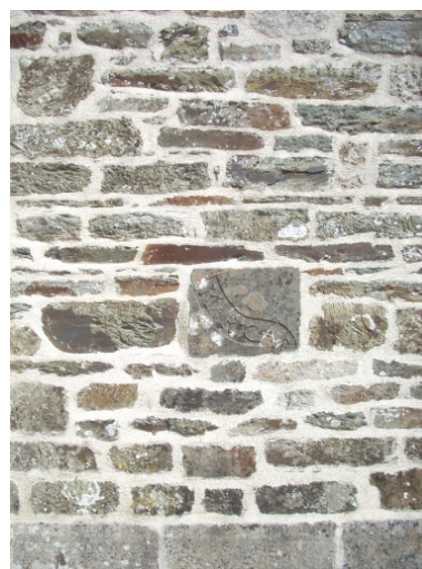
Landeleau, église paroissiale Saint- Théleau : détail du gros oeuvre Phot. Gwénaél Fauchille IVR53_20082905561NUCA
