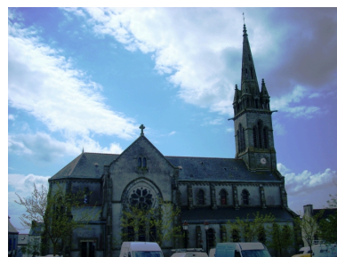
Plogastel-Saint-Germain, église paroissiale Saint-Pierre : vue générale nord Phot. Gwénaél Fauchille IVR53_20082905786NUCA
