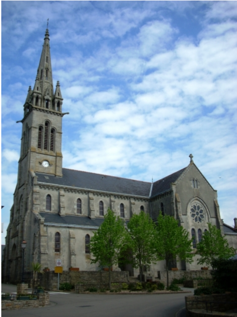
Plogastel-Saint-Germain, église paroissiale Saint-Pierre : vue générale sud-ouest
