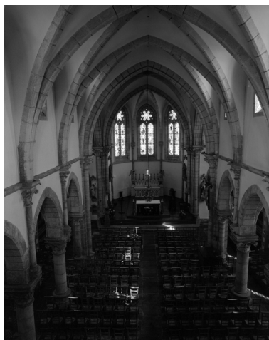
Plogastel-Saint-Germain, église paroissiale Saint-Pierre : intérieur, vue prise vers l'est, état en 1982 Phot. Guy Artur IVR53_19822900172X
