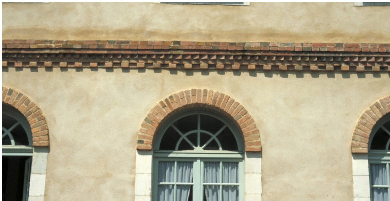
Détail sur la façade nord
