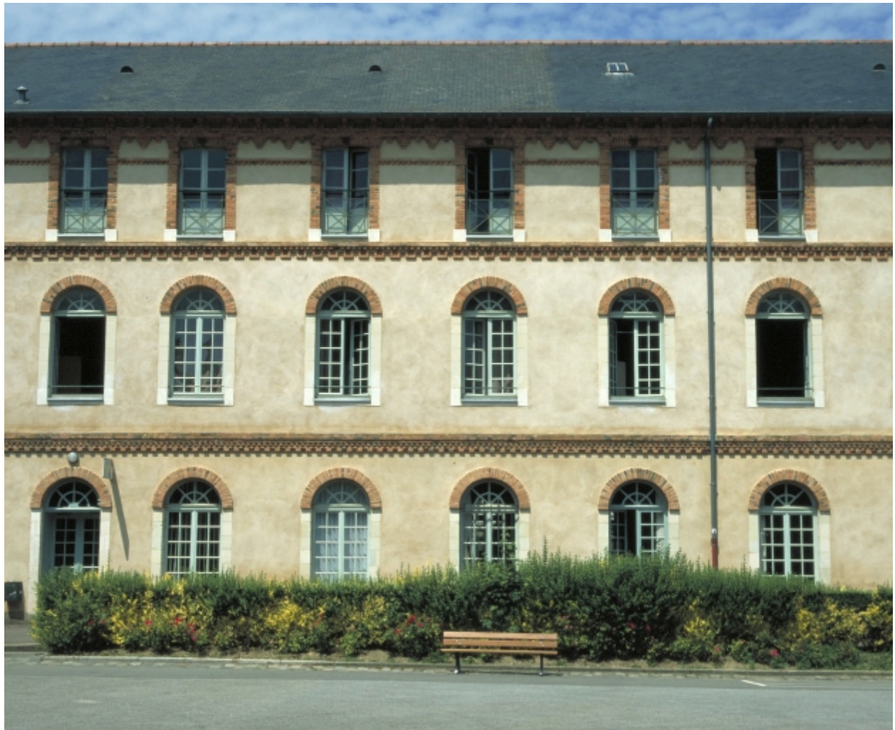
Vue de la façade sud
