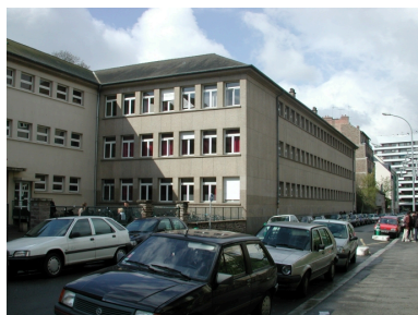
Vue de la façade nord de l'aile ouest construite par Yves Lemoine Phot. Isabelle Barbedor IVR53_20013521479NUCA
