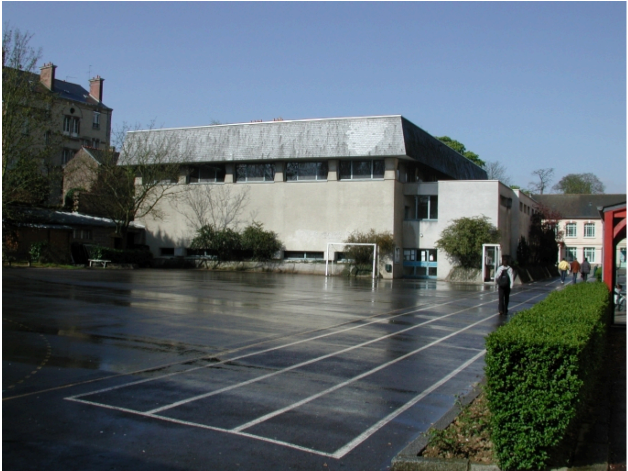
Vue du gymnase
