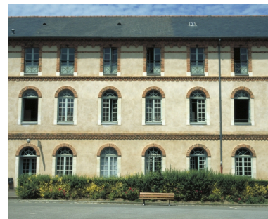
Vue de la façade sud Phot. Guy Artur IVR53_20023501346XA
