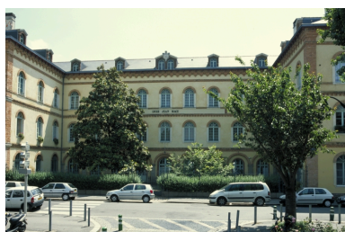
Détail sur la façade nord du corps central Phot. Guy Artur IVR53_20023501343XA
