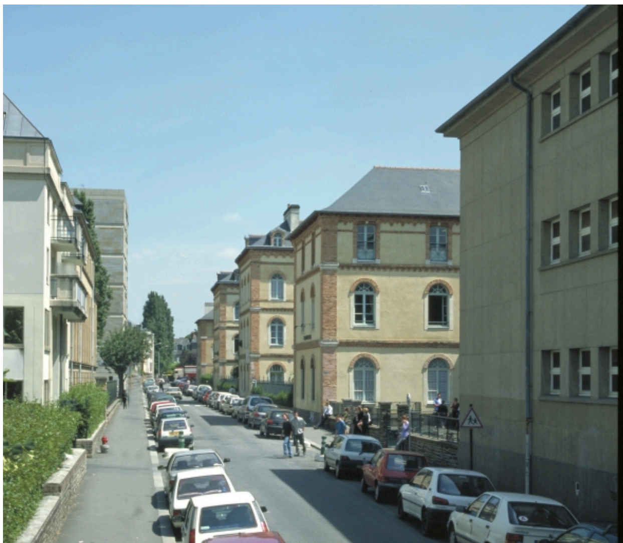
Vue de situation, depuis le nord-ouest
