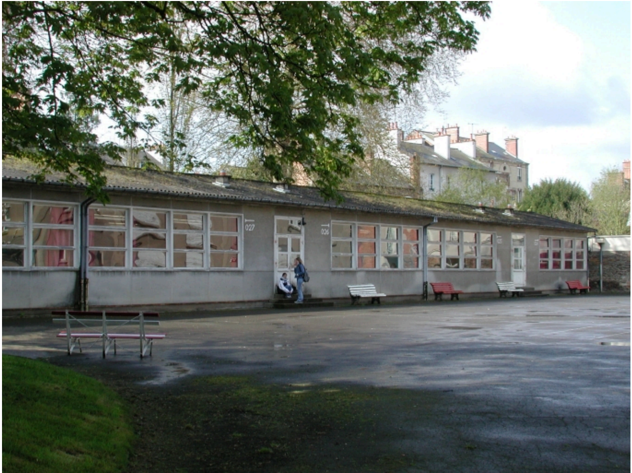
Vue des baraquements construits au sud de la cour
