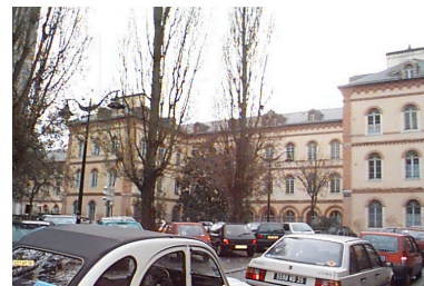
Vue depuis le nord-ouest Phot. C. Guillot IVR53_19983504808NUCA
