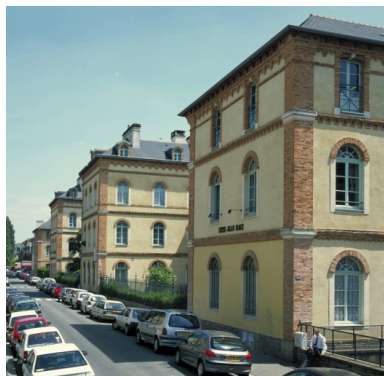
Vue de situation, depuis le nord-ouest Phot. Guy Artur IVR53_20023501342XA
