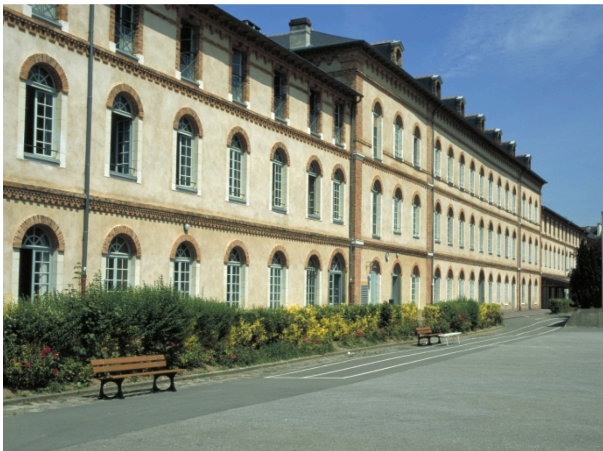
Vue de la façade sud, depuis le sud-ouest
