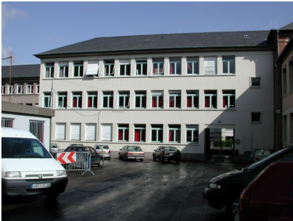
Vue de la façade sud de l'aile ouest construite par Yves Lemoine dans le prolongement des bâtiments de Langlois
