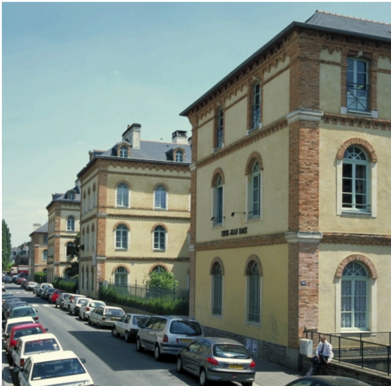
Vue de situation, depuis le nord-ouest
