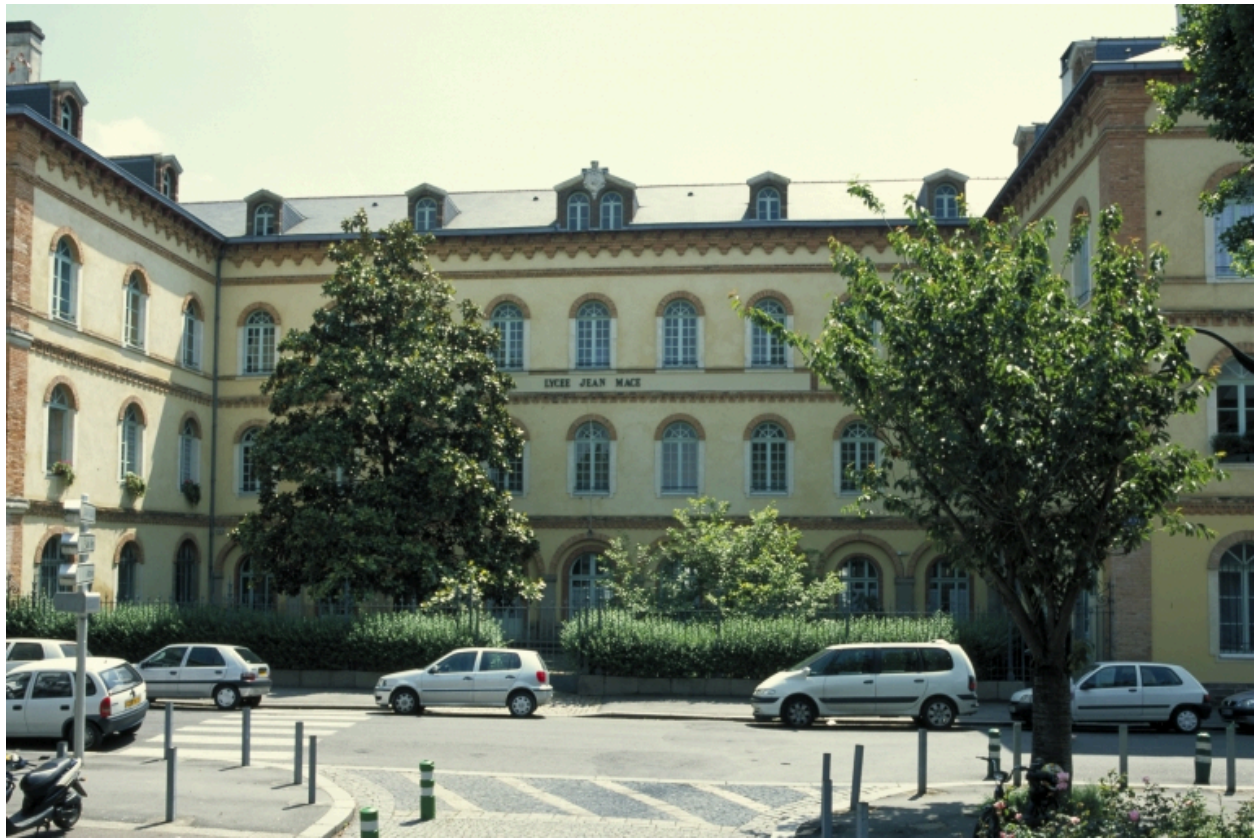
Détail sur la façade nord du corps central
