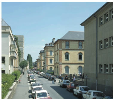
Vue de situation, depuis le nord-ouest Phot. Guy Artur IVR53_20023501341XA
