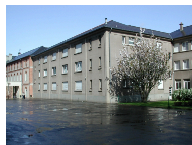
Vue de la façade sud de l'aile construite par Yves Lemoine dans le prolongement des bâtiments de Langlois Phot. Isabelle Barbedor IVR53_20013521473NUCA
