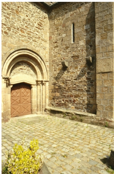
Portail sud : vue rapprochée. Phot. Claude Quillivic IVR53_19943502442ZA
