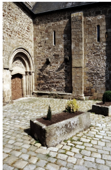
Portail sud : vue générale prise du sud-ouest. Phot. Claude Quillivic IVR53_19943502441ZA
