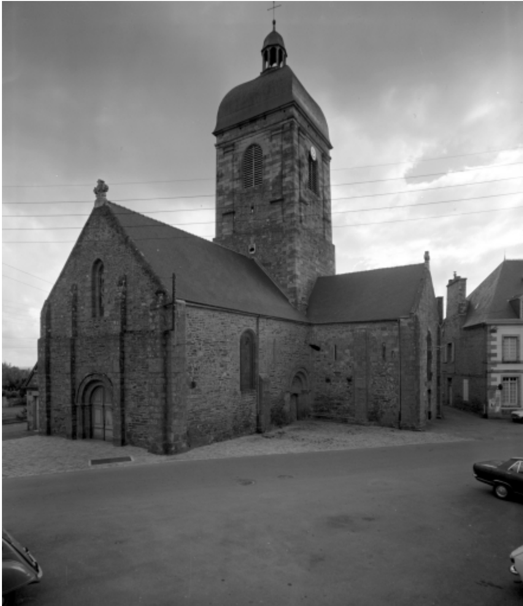
Elévation Sud-Ouest : vue générale
