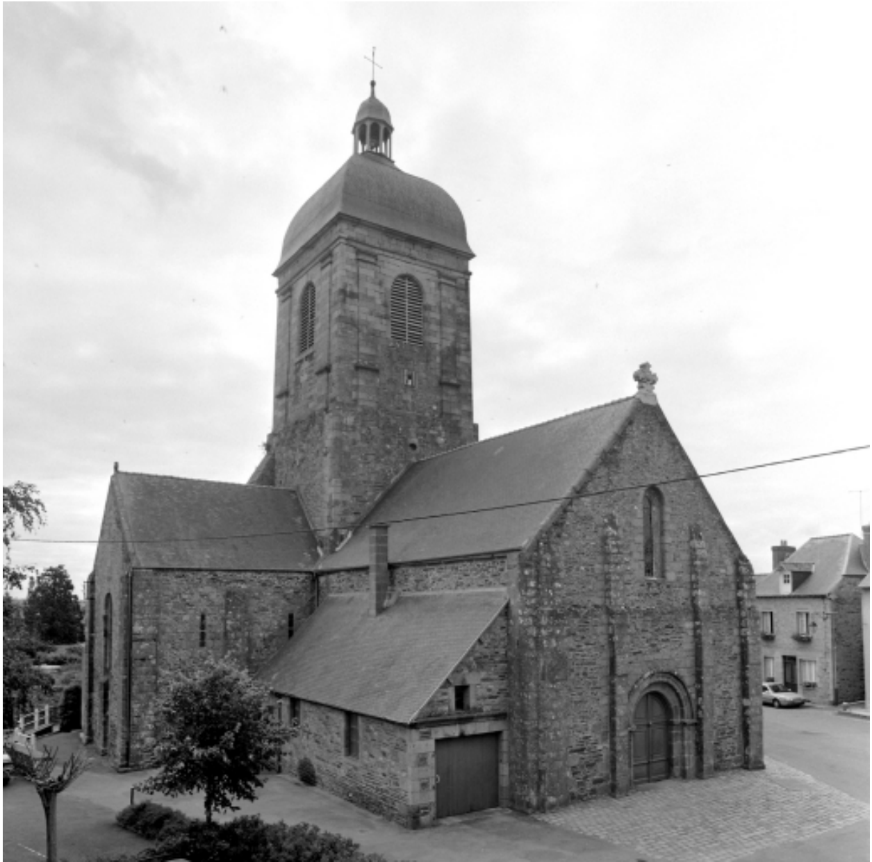
Elévation Nord-Ouest : vue générale
