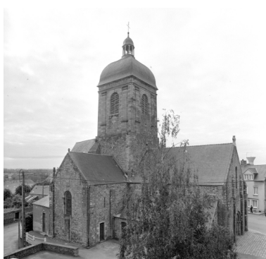
Élévation Nord : vue générale Phot. Guy Artur, Phot. Norbert Lambart IVR53_19943501260X
