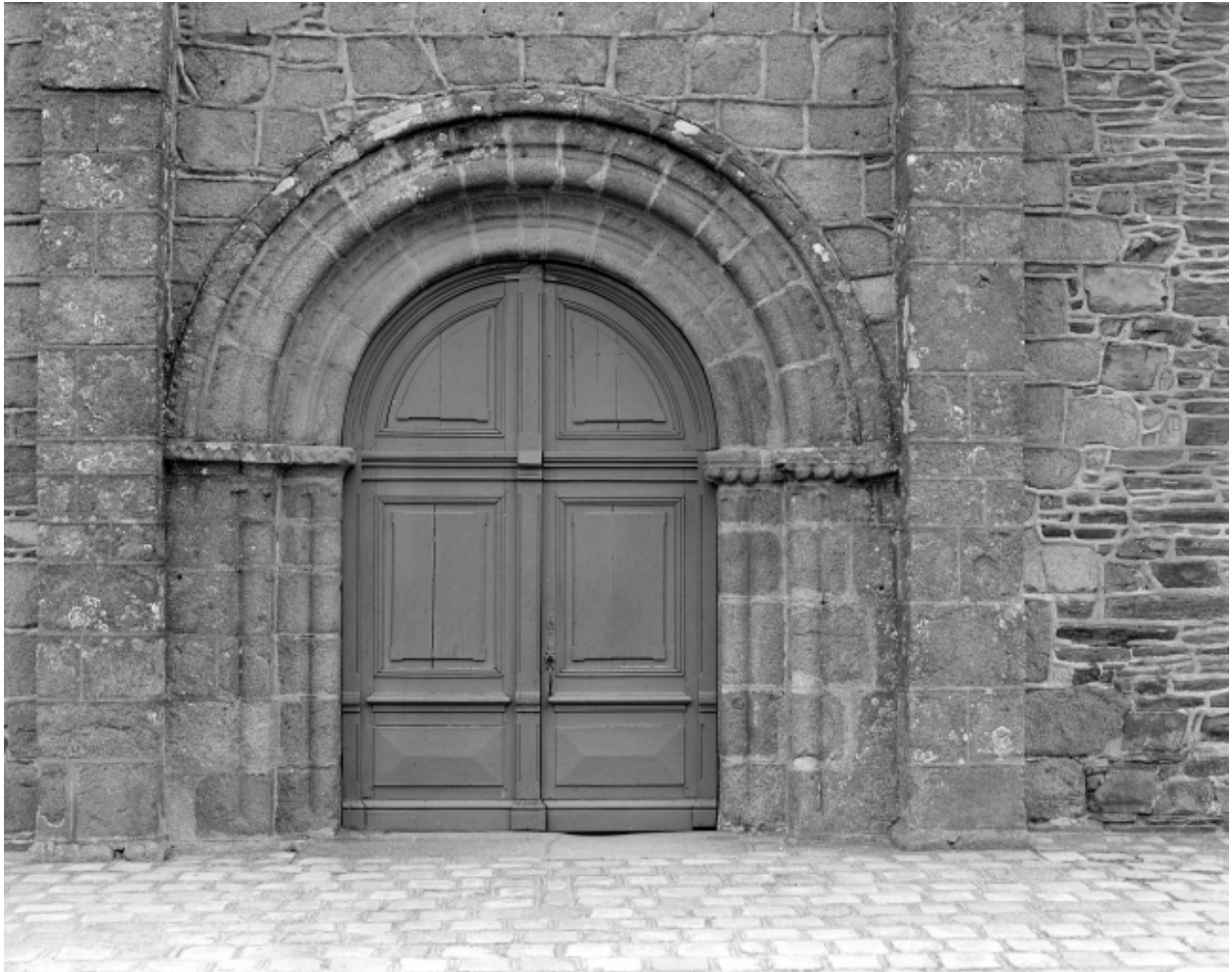
Elévation Ouest, portail : vue générale
