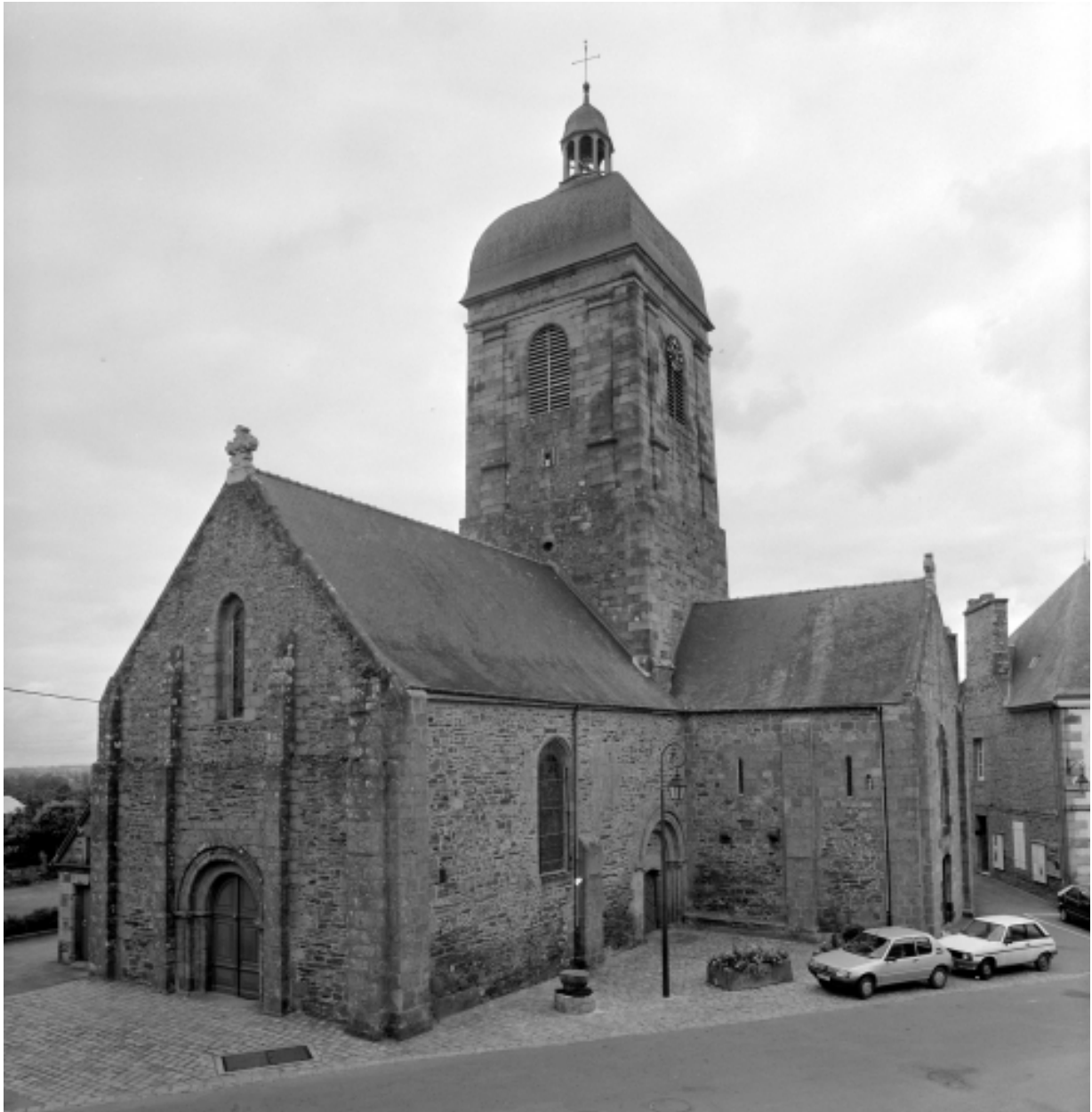
Elévation Sud-Ouest : vue générale
