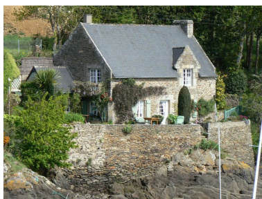
Maison Beg Roudou vue de biais Phot. Julien Amghar IVR53_20082908565NUCA
