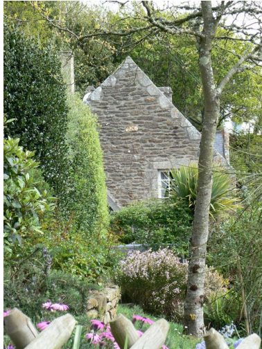
Pignon sud-ouest de la maison Beg Roudou Phot. Julien Amghar IVR53_20082908568NUCA
