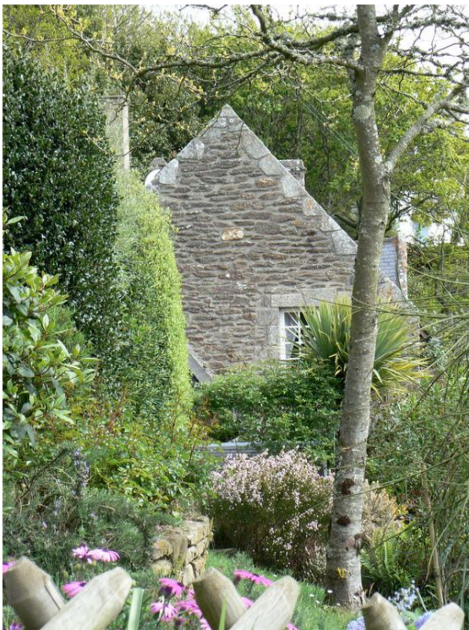
Pignon sud-ouest de la maison Beg Roudou
