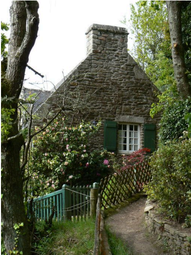
Pignon nord-est de la maison Beg Roudou Phot. Julien Amghar IVR53_20082908567NUCA
