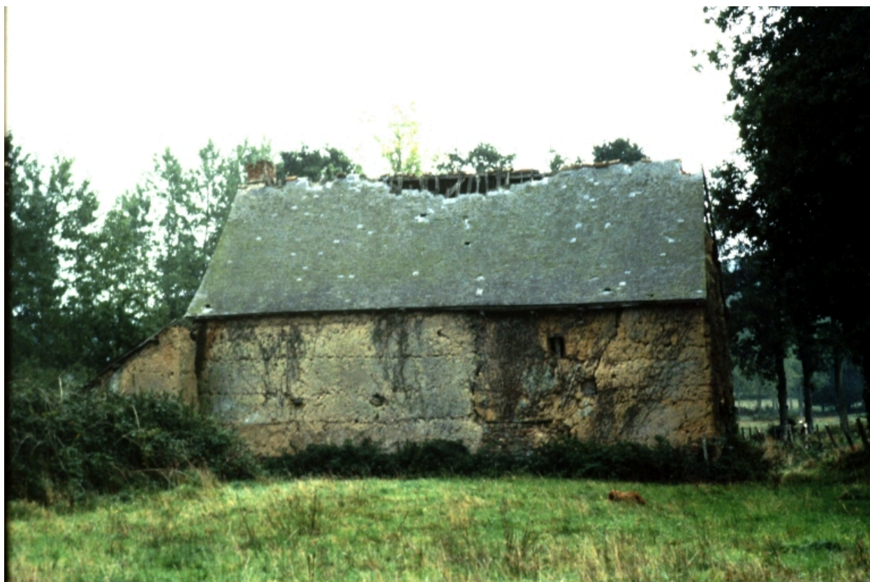
Elévation antérieure, vue générale.
