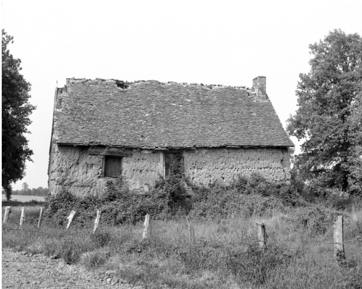
Elévation antérieure, vue générale.
