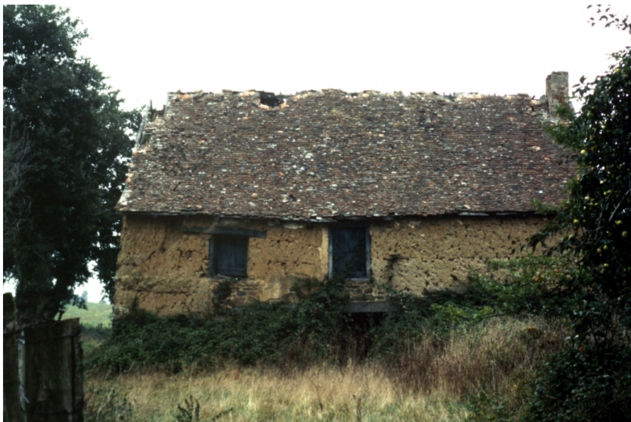
Elévation antérieure, vue générale.
