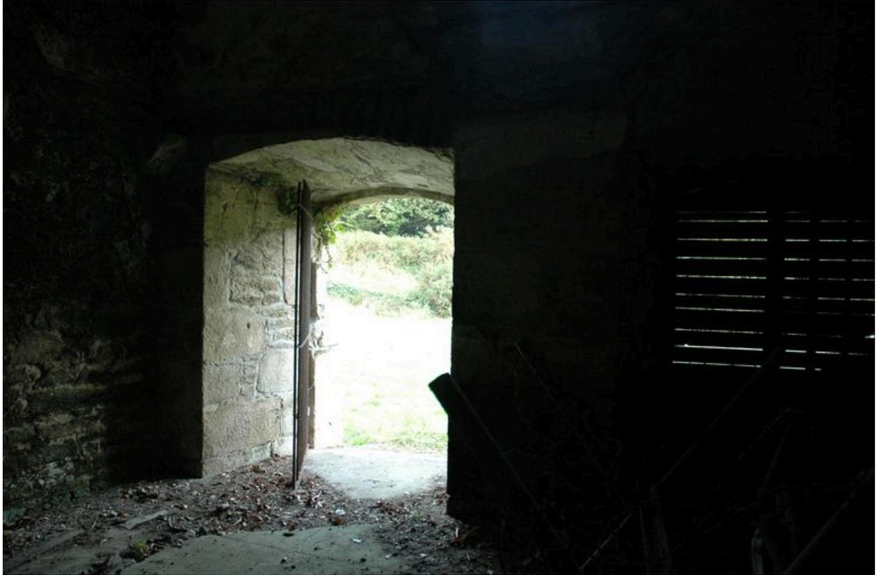
Vue du fort de Penfeld : exemple de caserne voûtée avec entresol sur corbeaux accessible par une échelle. La pièce dotée d'une cheminée au rez-de-chaussée comporte une porte et deux baies ouvrant sur la place d'armes
