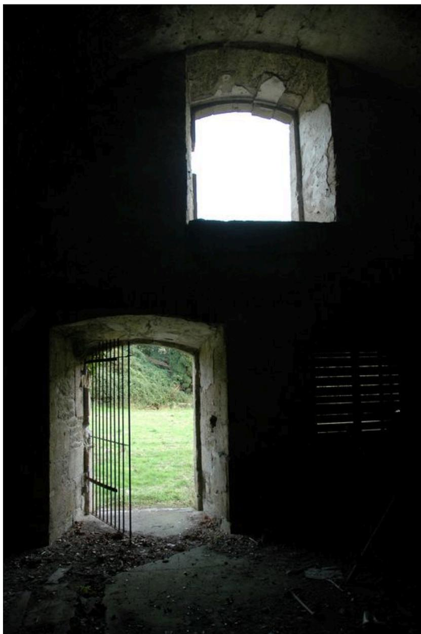
Vue du fort de Penfeld : exemple de caserne voûtée avec entresol sur corbeaux accessible par une échelle. La pièce dotée d'une cheminée au rez-de-chaussée comporte une porte et deux baies ouvrant sur la place d'armes
