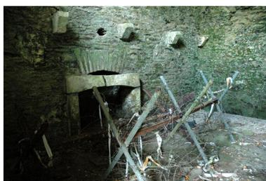
Vue du fort de Penfeld : exemple de caserne voutée avec entresol sur corbeaux accessible par une échelle. La pièce dotée d'une cheminée au rez-de-chaussée comporte une porte et deux baies ouvrant sur la place d'armes
