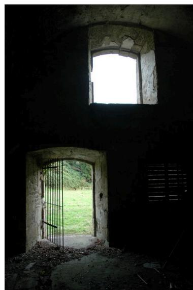
Vue du fort de Penfeld : exemple de caserne voutée avec entresol sur corbeaux accessible par une échelle. La pièce dotée d'une cheminée au rez-de-chaussée comporte une porte et deux baies ouvrant sur la place d'armes
