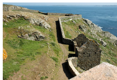
Vue générale depuis la plate- forme de la redoute (état en 2006) Phot. Guillaume Lécueillier IVR53_20062210074NUCA
