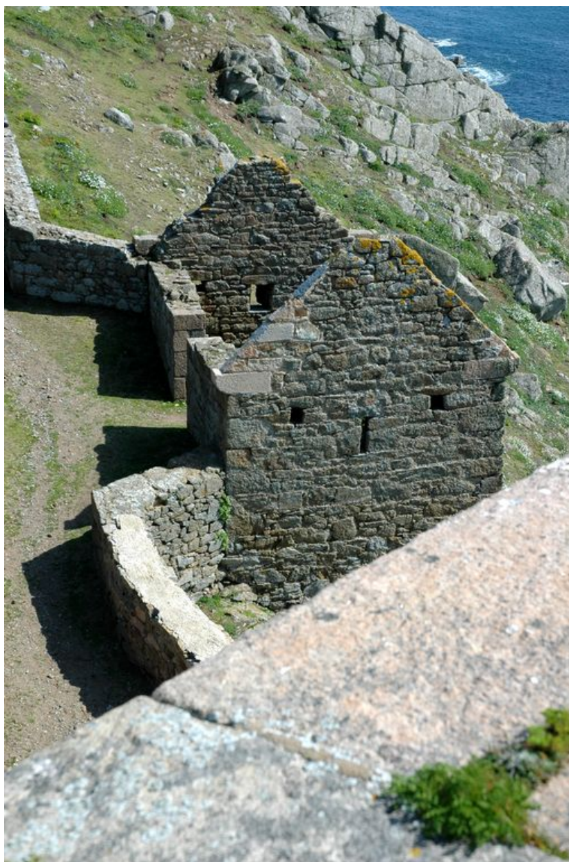
Vue générale depuis la plate-forme de la redoute (état en 2006)
