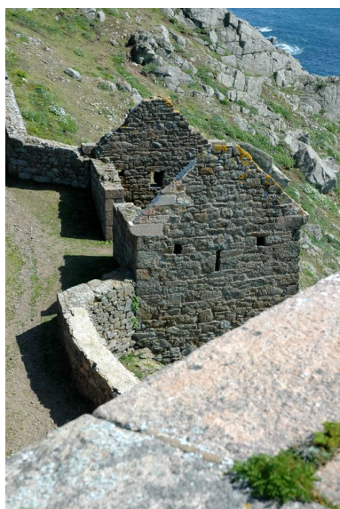
Vue générale depuis la plate- forme de la redoute (état en 2006) Phot. Guillaume Lécueillier IVR53_20062210075NUCA
