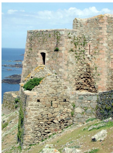
Vue de situation (état en 2002). Au premier plan, le pignon sud-est. En arrière-plan, la redoute Phot. Guillaume Lécueillier IVR53_20022202543NUCA
