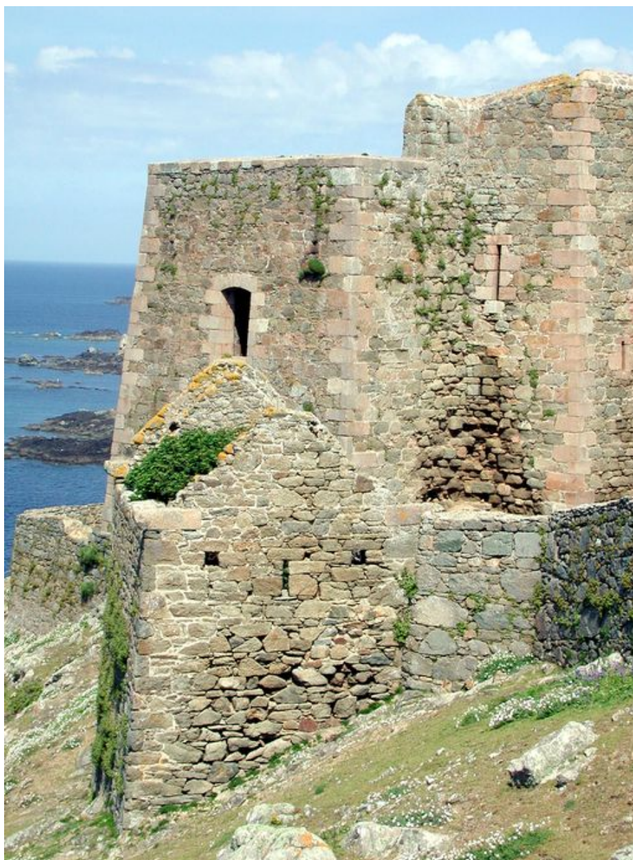
Vue de situation (état en 2002). Au premier plan, le pignon sud-est. En arrière-plan, la redoute
