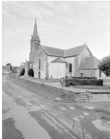
Elévation Sud-Est : vue générale. Phot. Guy Artur, Phot. Norbert Lambart IVR53_19943501785X
