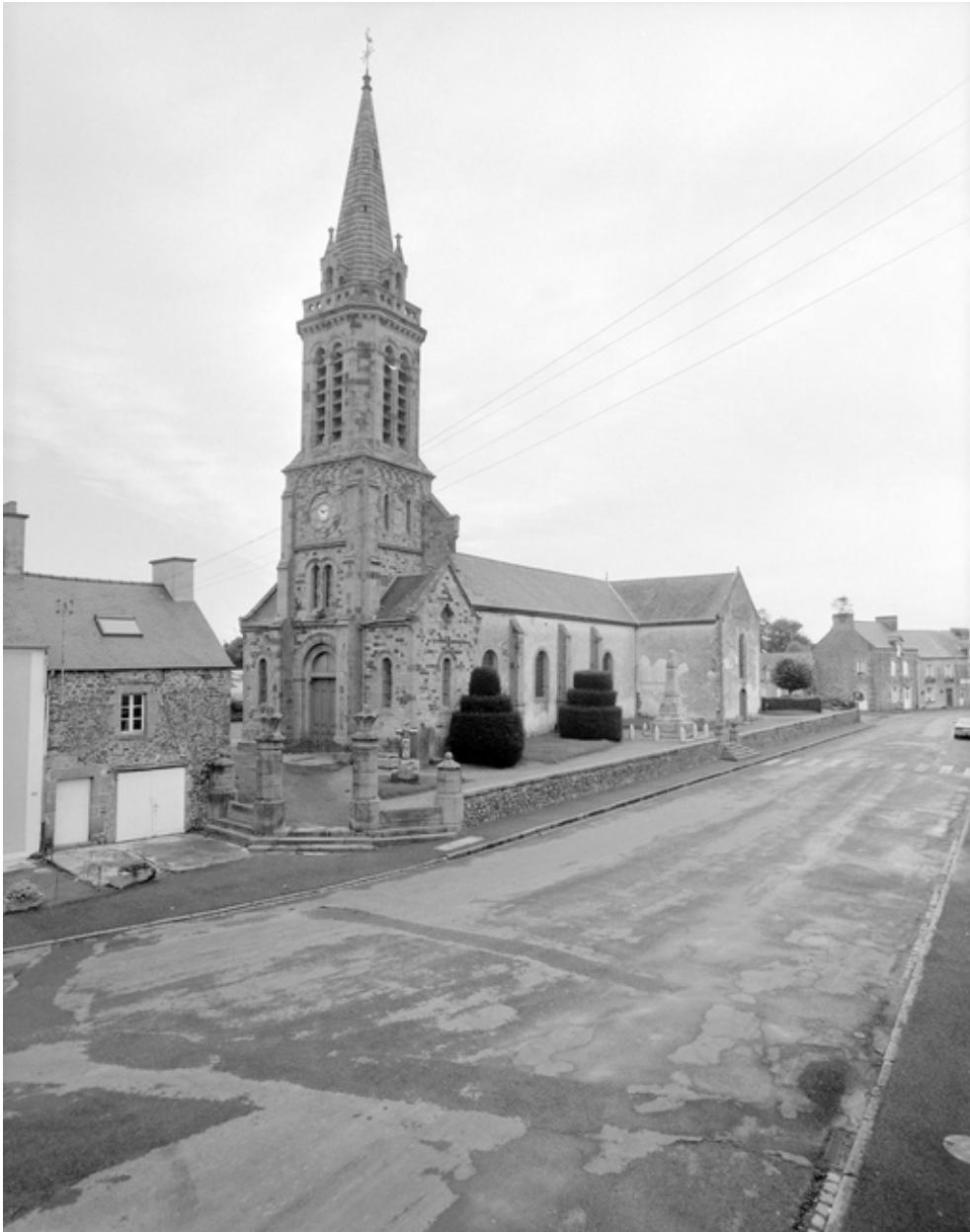
Elévation Sud-Ouest : vue générale.
