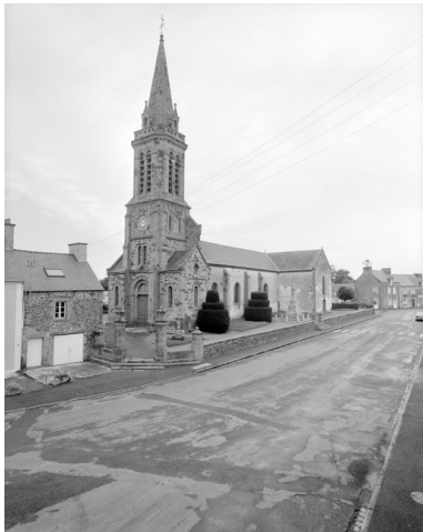
Elévation Sud-Ouest : vue générale. Phot. Guy Artur, Phot. Norbert Lambart IVR53_19943501784X
