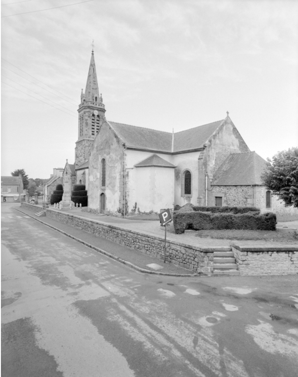
Elévation Sud-Est : vue générale.
