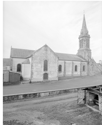
Elévation Nord : vue générale. Phot. Guy Artur, Phot. Norbert Lambart IVR53_19943501786X
