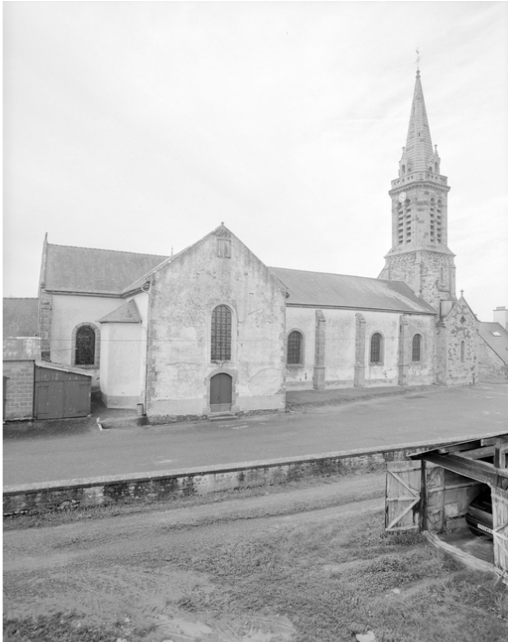
Elévation Nord : vue générale.
