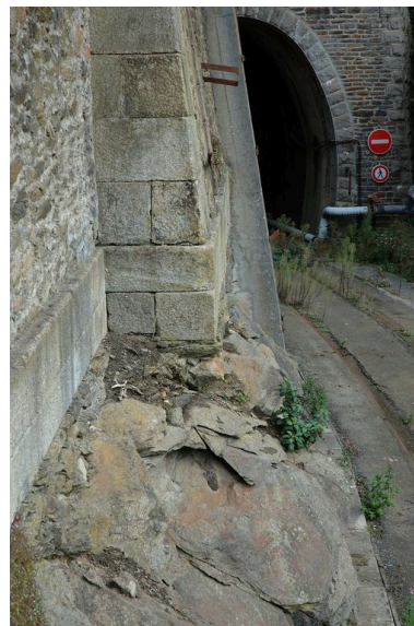
Vue de détail des fondations en pierre de taille de granite sur le socle rocheux. En arrière- plan, le tunnel ferroviaire (1932) Phot. Guillaume Lécueillier IVR53_20072906732NUCA
