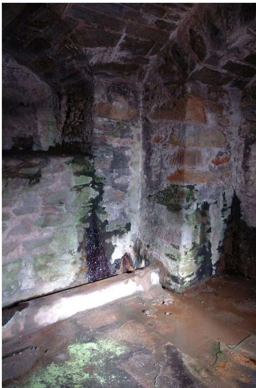
Vue intérieure : galerie voûtée du sous-sol, système de collectage des eaux d'infiltration
