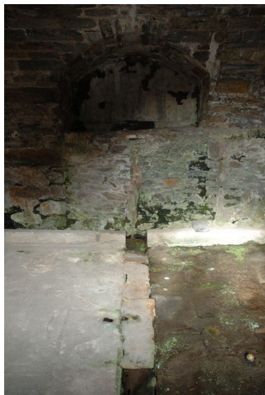
Vue intérieure : galerie voûtée du sous-sol, système de collectage des eaux d'infiltration Phot. Guillaume Lécueillier IVR53_20072906729NUCA
