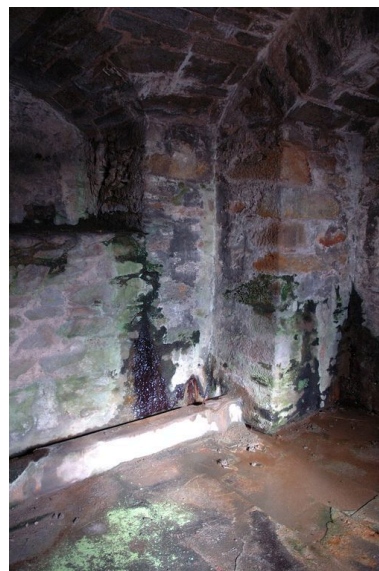
Vue intérieure : galerie voûtée du sous-sol, système de collectage des eaux d'infiltration Phot. Guillaume Lécueillier IVR53_20072906728NUCA
