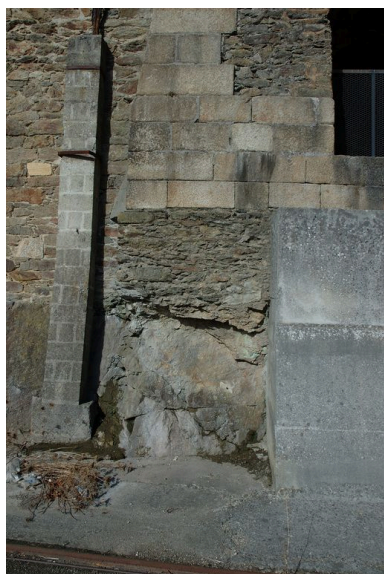
Vue de détail des fondations en pierre de taille de granite sur le socle rocheux (angle sud) Phot. Guillaume Lécueillier IVR53_20072906769NUCA
