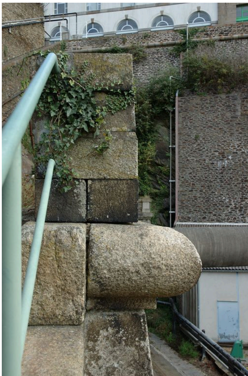
Vue de détail : appareillage en granite (profil)
