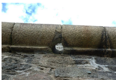
Vue de détail d'un emplacement de descente d'eau pluviale dans le cordon en granite Phot. Guillaume Lécueillier IVR53_20072906731NUCA
