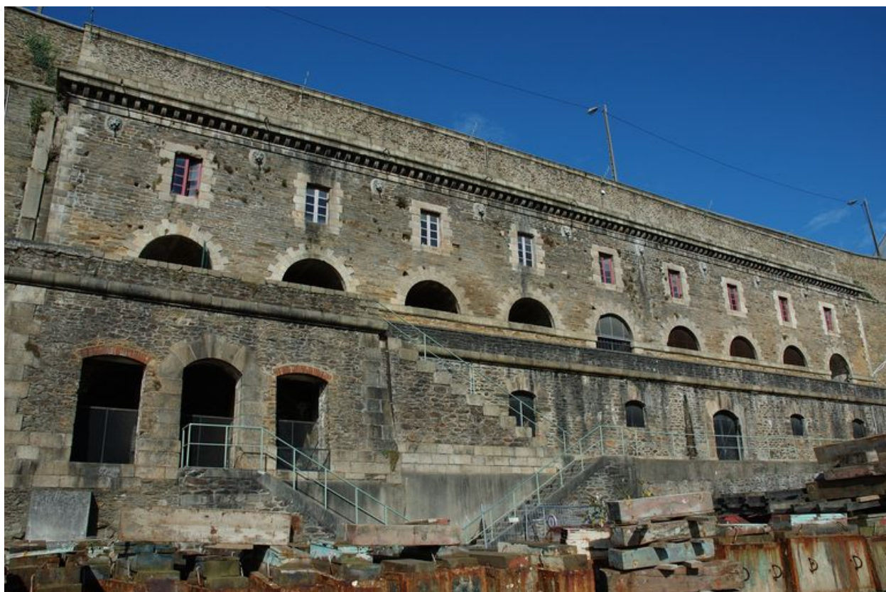
Vue générale de l'élévation orientale (contre-plongée)
