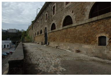
Vue de l'élévation orientale (contre-plongée) : chaussée - terrasse pavée, passage central au niveau du rez-de-chaussée et baies en arc plein cintre. En arrière-plan, la rampe menant au plateau de Pontaniou
