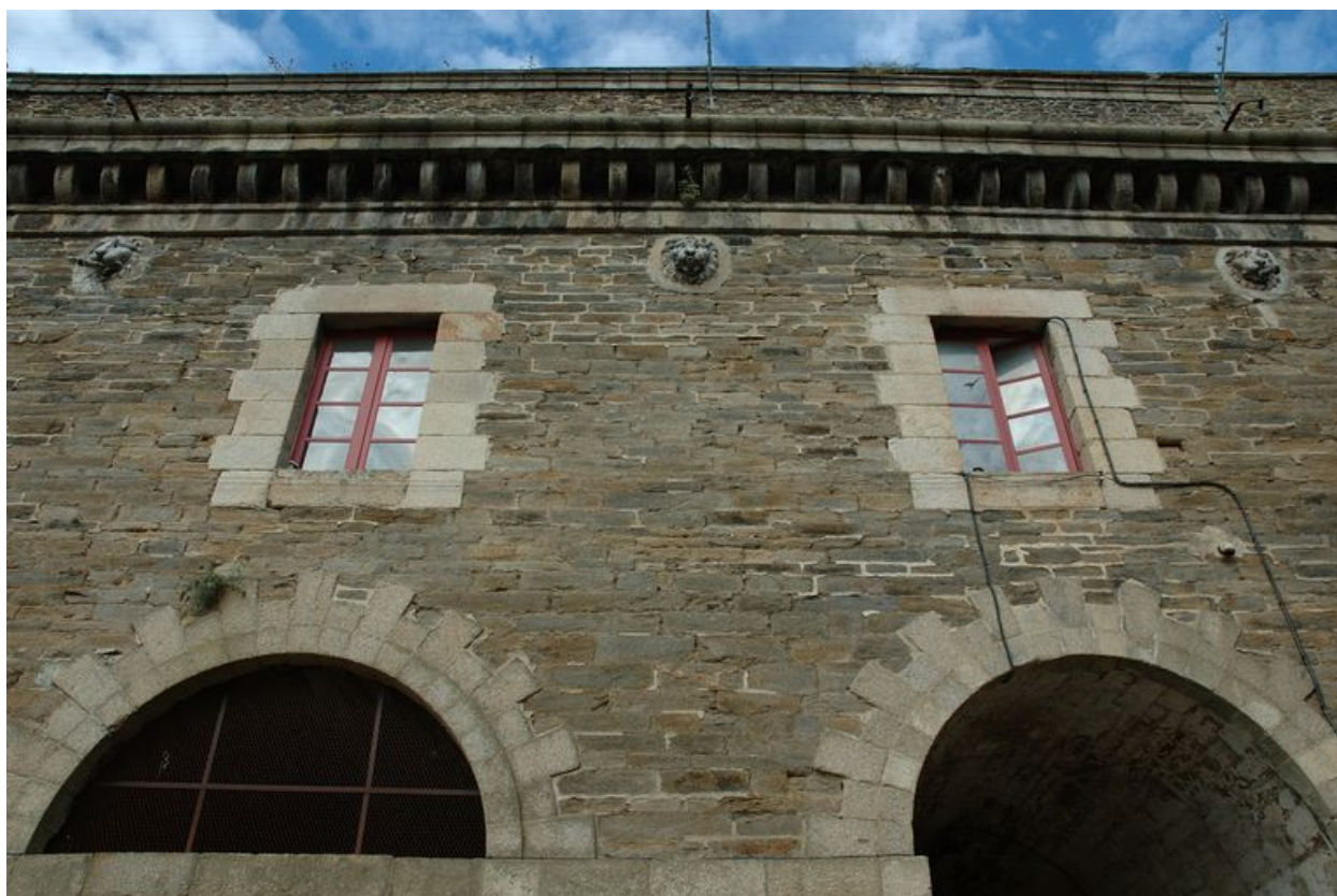
Vue de l'élévation orientale (contre-plongée) : baies en arc plein cintre, fenêtres rectangulaires et gargouilles ornées de tête de lion
