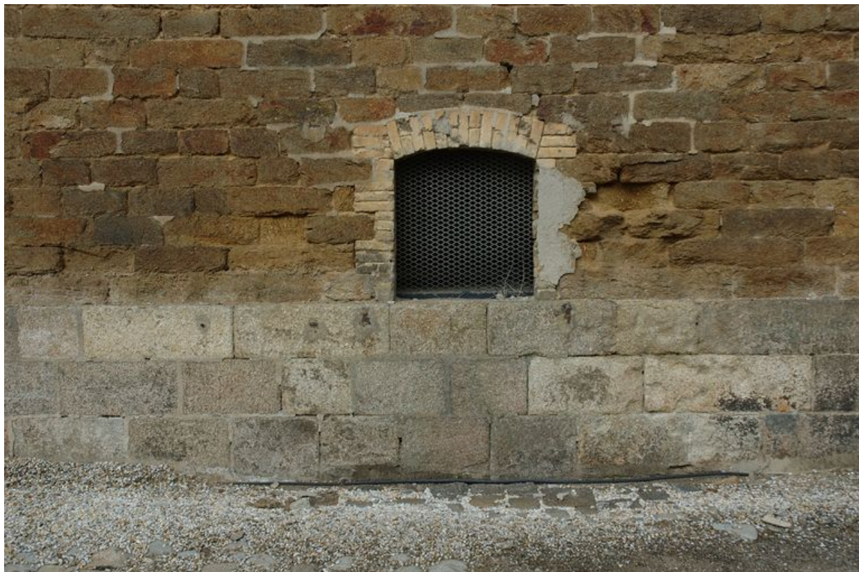
Vue de détail d'une descente d'eau pluviale
