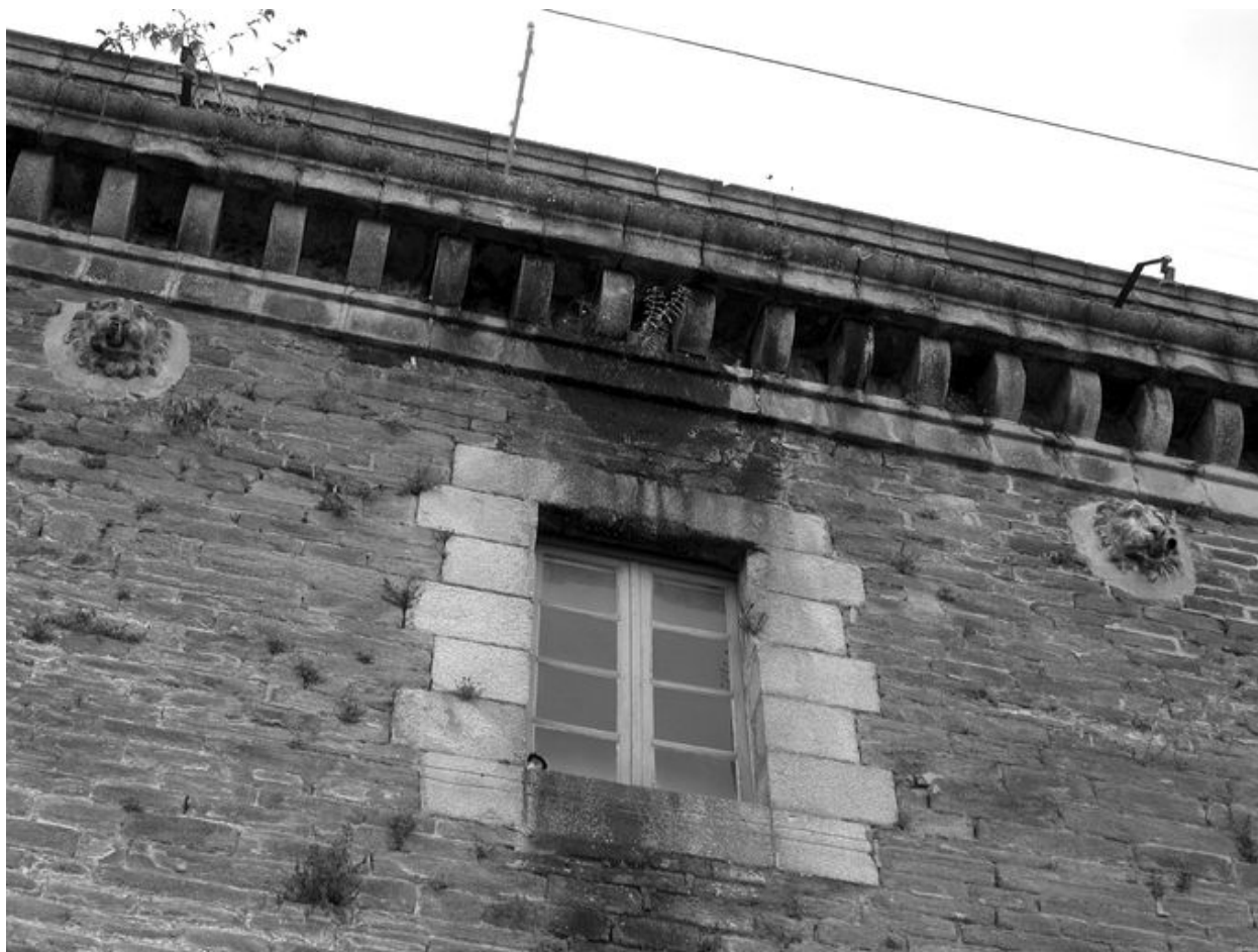
Détail de la façade orientale : corniche surmontée de réservoirs, gargouilles ornées de tête de lion et fenêtre rectangulaire du premier étage
