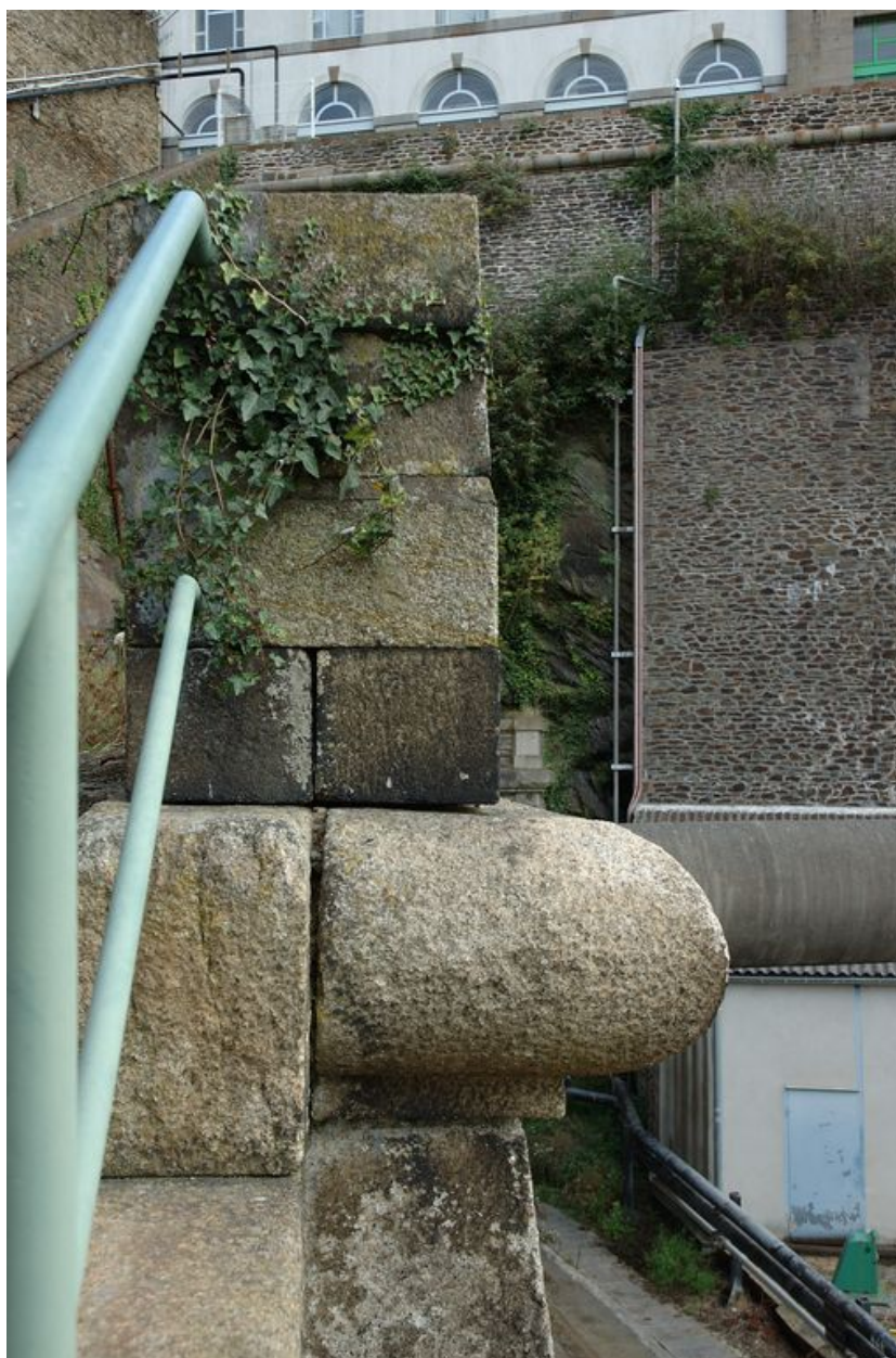
Vue de détail : appareillage en granite (profil)
