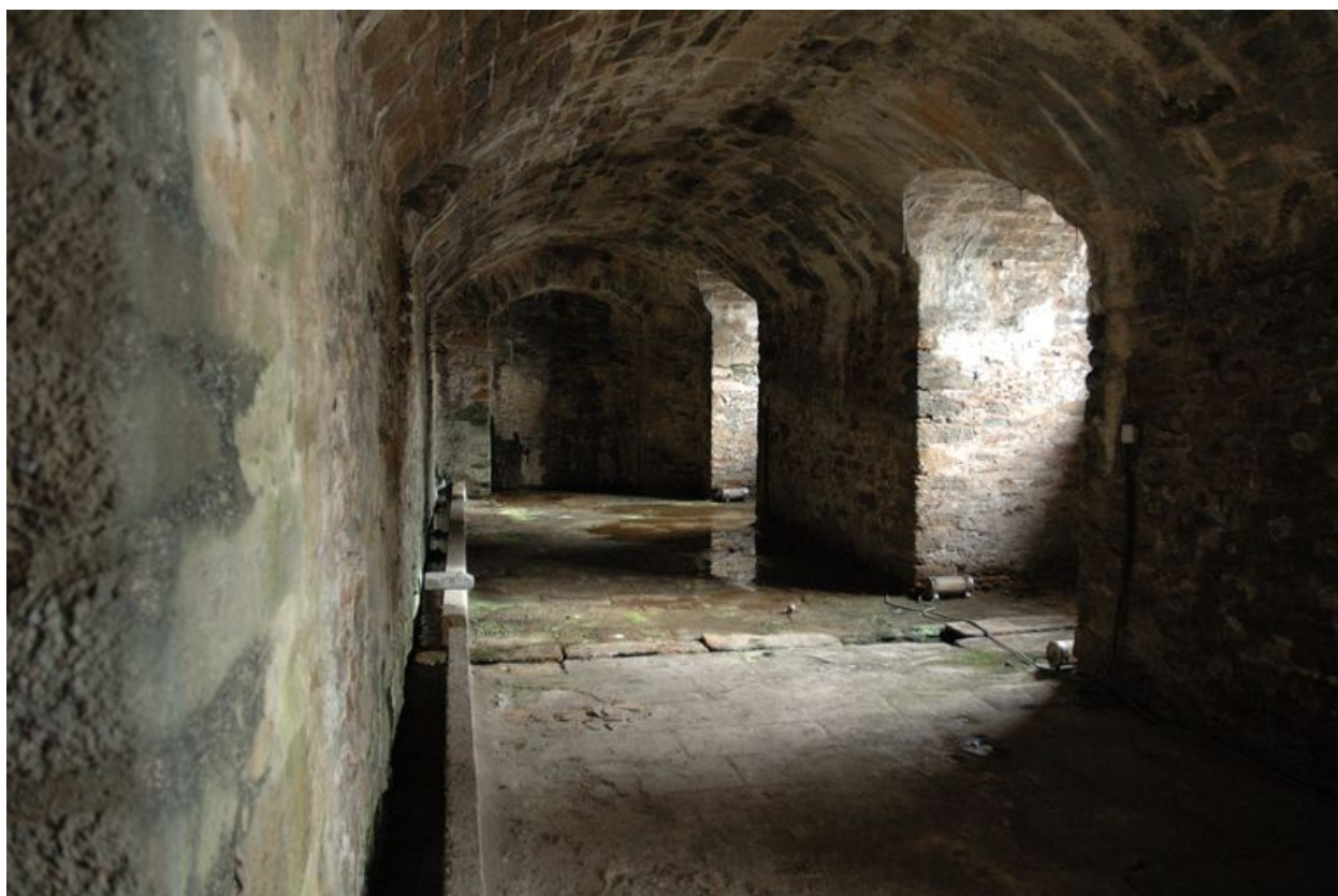
Vue intérieure : galerie voûtée du sous-sol
