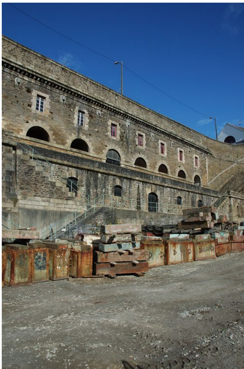
Vue de l'élévation orientale (contre-plongée)
