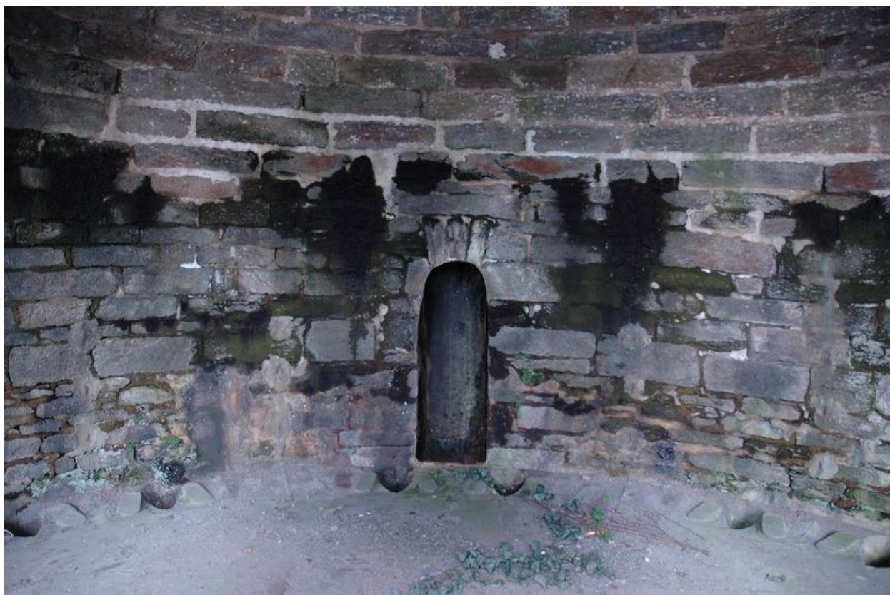
Vue intérieure des latrines collectives
