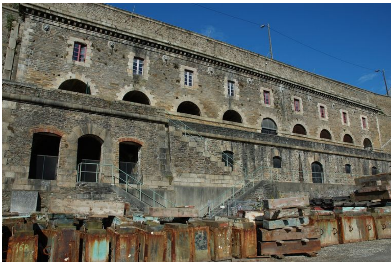
Vue générale de l'élévation orientale (contre-plongée)
