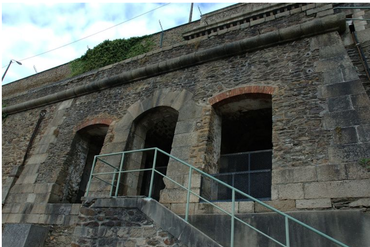
Vue des latrines collectives (contre-plongée)
