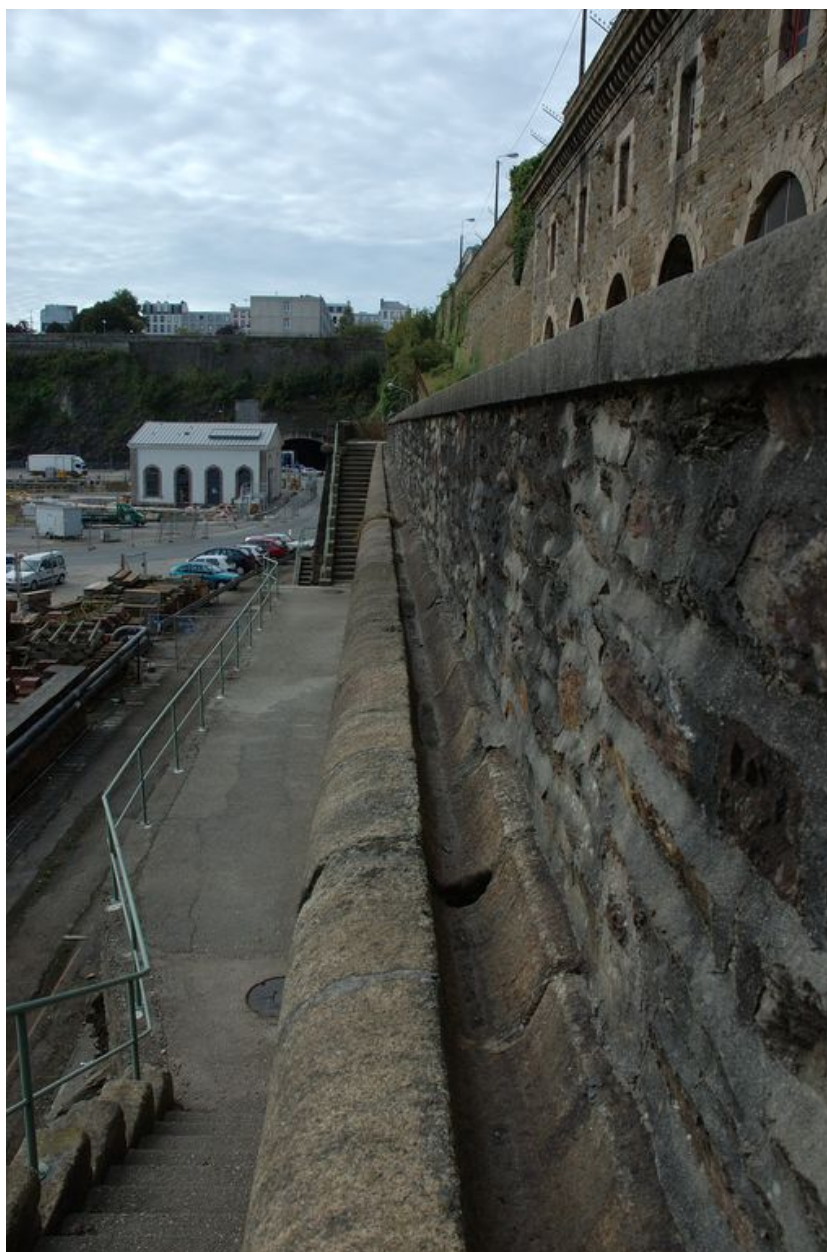
Vue de détail : rigole en granite destinée à collecter les eaux pluviales de la chaussée - terrasse supérieure
