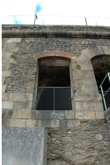
Vue des latrines collectives (contre-plongée) : porte gauche aménagée ultérieurement et détail de la maçonnerie en pierre de taille de granite Phot. Guillaume Lécueillier IVR53_20072906716NUCA
