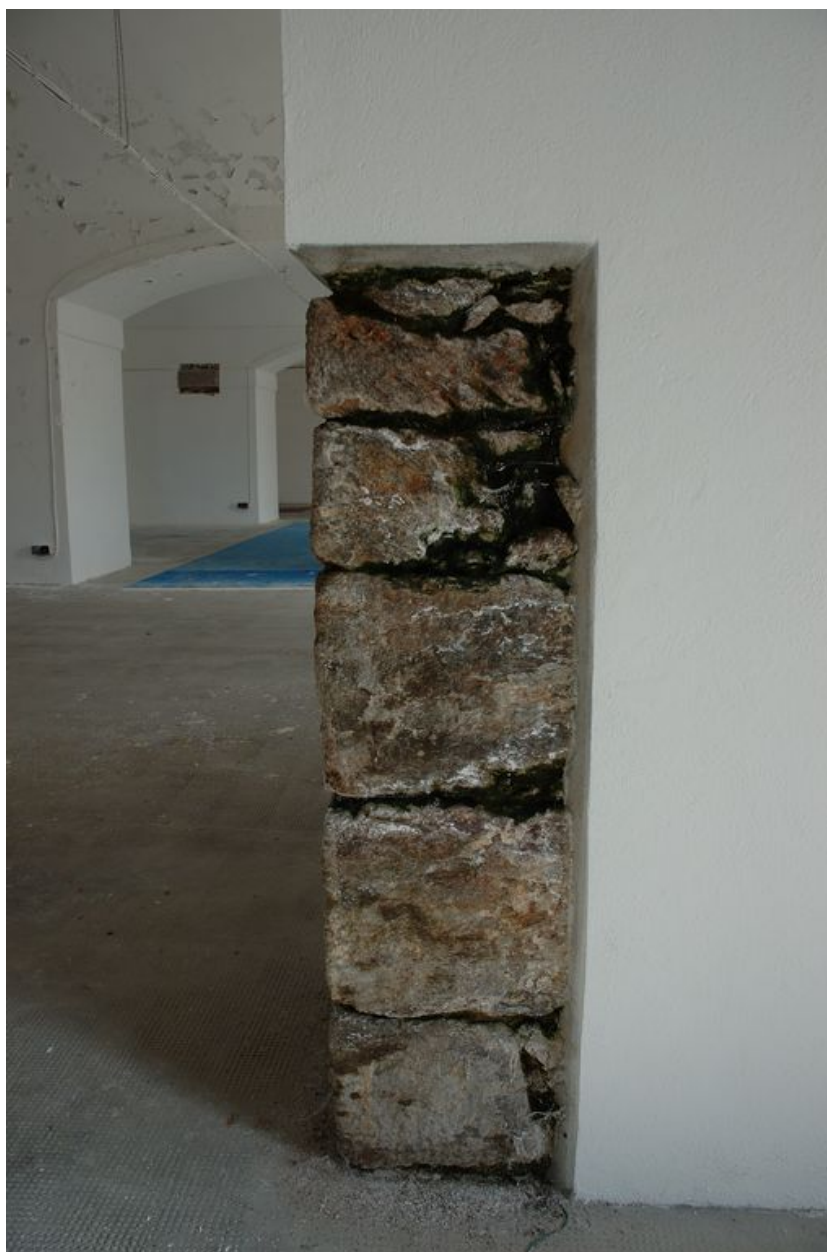
Vue intérieure : premier étage, maçonnerie révélée par le diagnostic (après piquage de l'enduit en ciment)
