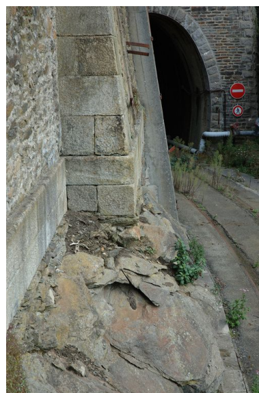
Vue de détail des fondations en pierre de taille de granite sur le socle rocheux. En arrière- plan, le tunnel ferroviaire (1932)
