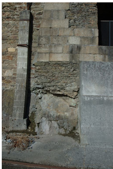
Vue de détail des fondations en pierre de taille de granite sur le socle rocheux (angle sud)
