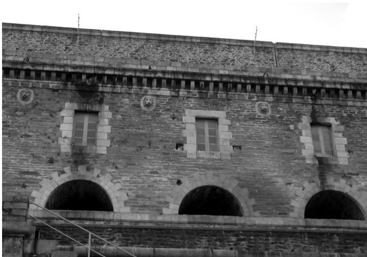
Détail de la façade orientale : corniche, gargouilles ornées de tête de lion, fenêtres rectangulaires et baies en arc plein cintre
