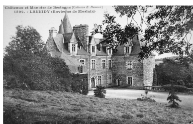
Vue générale Phot. Elise Lauranceau IVR53_20042905583NUCB
