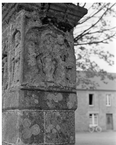
Soubassement : face nord ou sud Phot. François Dagorn IVR53_19752200556X
