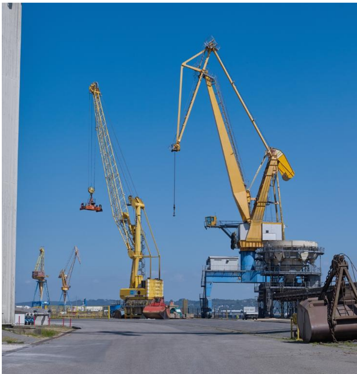
Grues et trémies du quai sud 6e bassin
