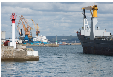
Chenal du port de Brest, passe Ouest : Grues du quai minéralier et des quais de réparation (2019, OPP port de Brest) Phot. Bernard Bègne IVR53_20192900518NUCA
