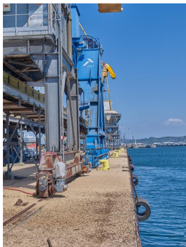
Grues sur rails et chemins de grues Phot. Bernard Bègne IVR53_20232900440NUCA
