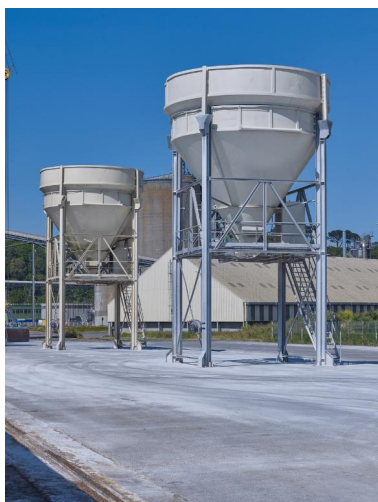
Trémies, 6e bassin Phot. Bernard Bègne IVR53_20232900394NUCA
