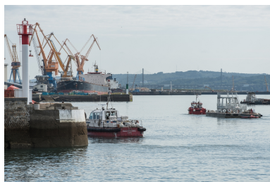
Chenal du port de Brest, passe Ouest : Grues du quai minéralier et des quais de réparation (2018, OPP port de Brest) Phot. Delia Gaulin-Crespel IVR53_20182900215NUCA
