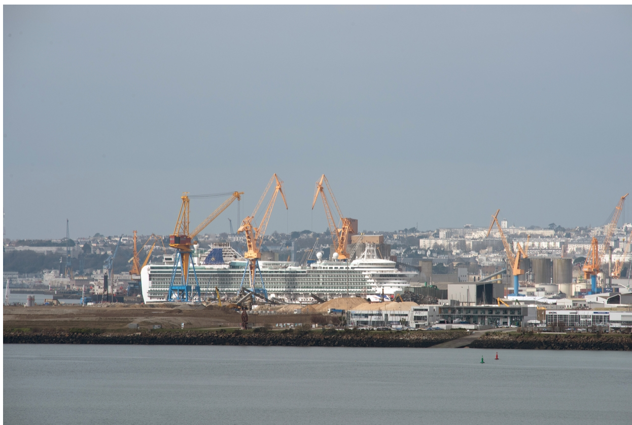
Paysage portuaire et urbain : activité maritime, réparation navale (2016, Observatoire photographique du polder du port de Brest)
