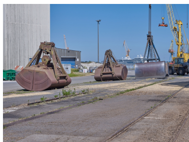
Godets de grues, quai sud, 6e bassin Phot. Bernard Bègne IVR53_20232900439NUCA
