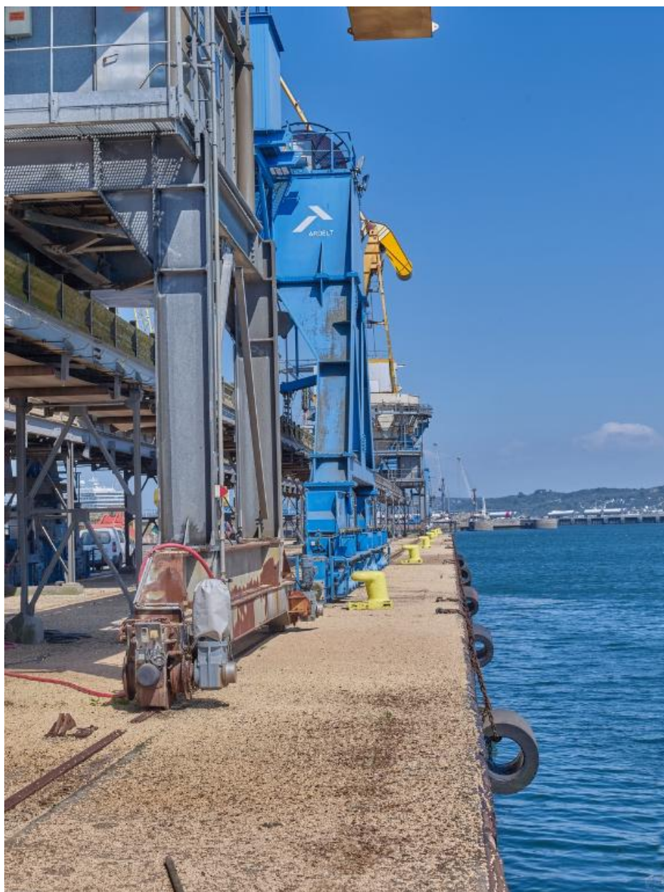
Grues sur rails et chemins de grues
