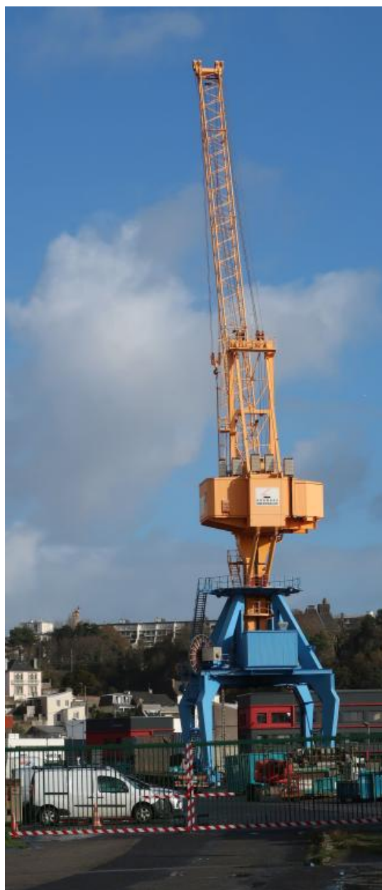
Grue Krambeu Eberswalde de la Forme de radoub 1
