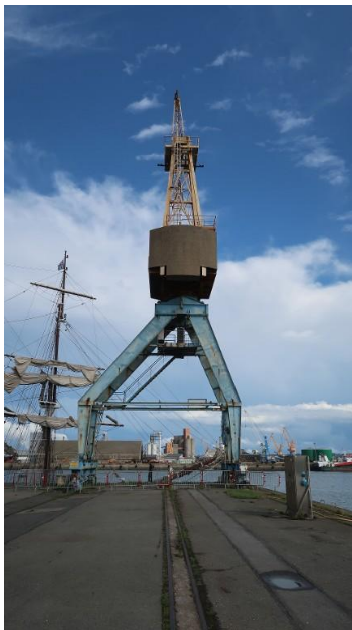
Grue Peiner n°1 située sur le 3e éperon
