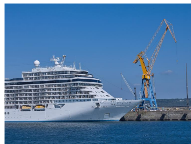
Paquebot à quai et grues de la forme n°3 Phot. Bernard Bègne IVR53_20232900366NUCA
