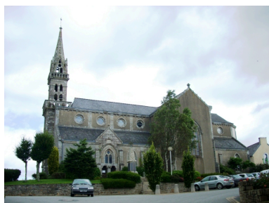
Botsorhel, église paroissiale Saint-Georges : vue générale sud-ouest Phot. Gwénaél Fauchille IVR53_20082906661NUCA
