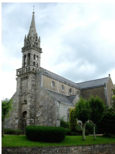
Botsorhel, église paroissiale Saint-Georges : vue générale sud-ouest Phot. Gwénaél Fauchille IVR53_20082906662NUCA
