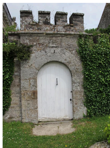
Le portail, avec la date portée de 1641 Phot. Véronique Orain IVR53_20162206942NUCA
