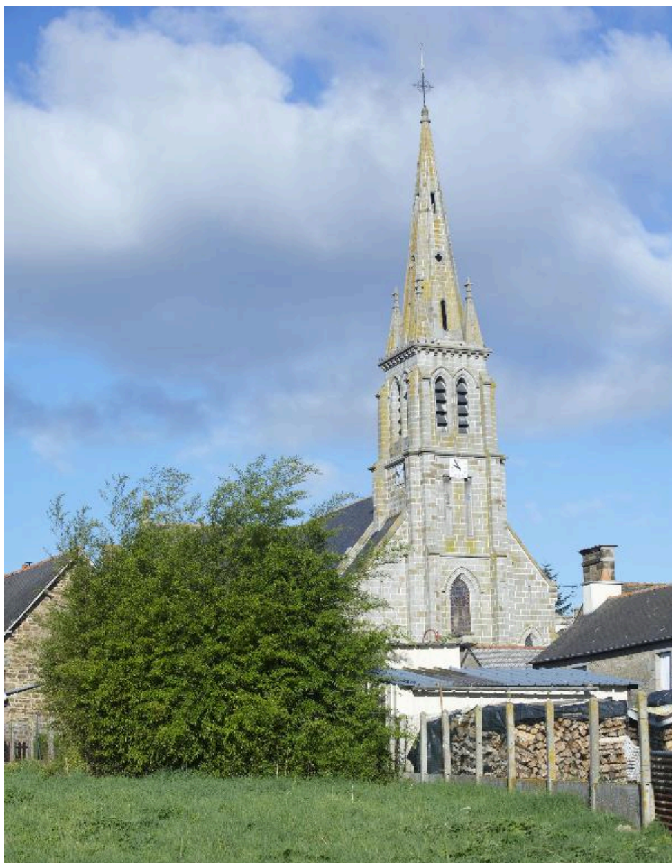
Vue générale sud-est de l'église
