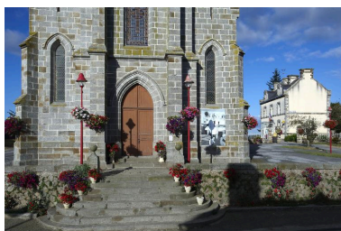
Détail de la façade Phot. Norbert Lambart IVR53_20123517045NUCA
