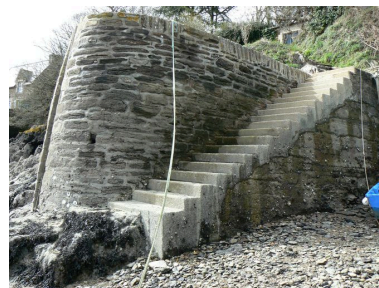
Escalier du môle 'Joseph Tonnerre' permettant l'accès à l'estran Phot. Julien Amghar IVR53_20082908578NUCA
