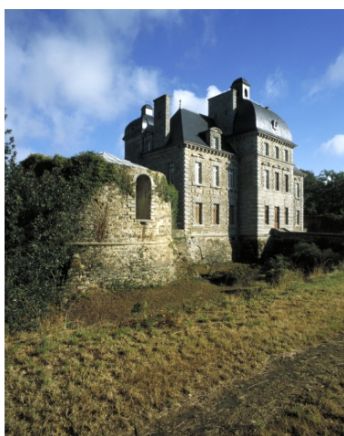
Vue générale sud-ouest Phot. Guy Artur, Phot. Norbert Lambart IVR53_19982200600XA
