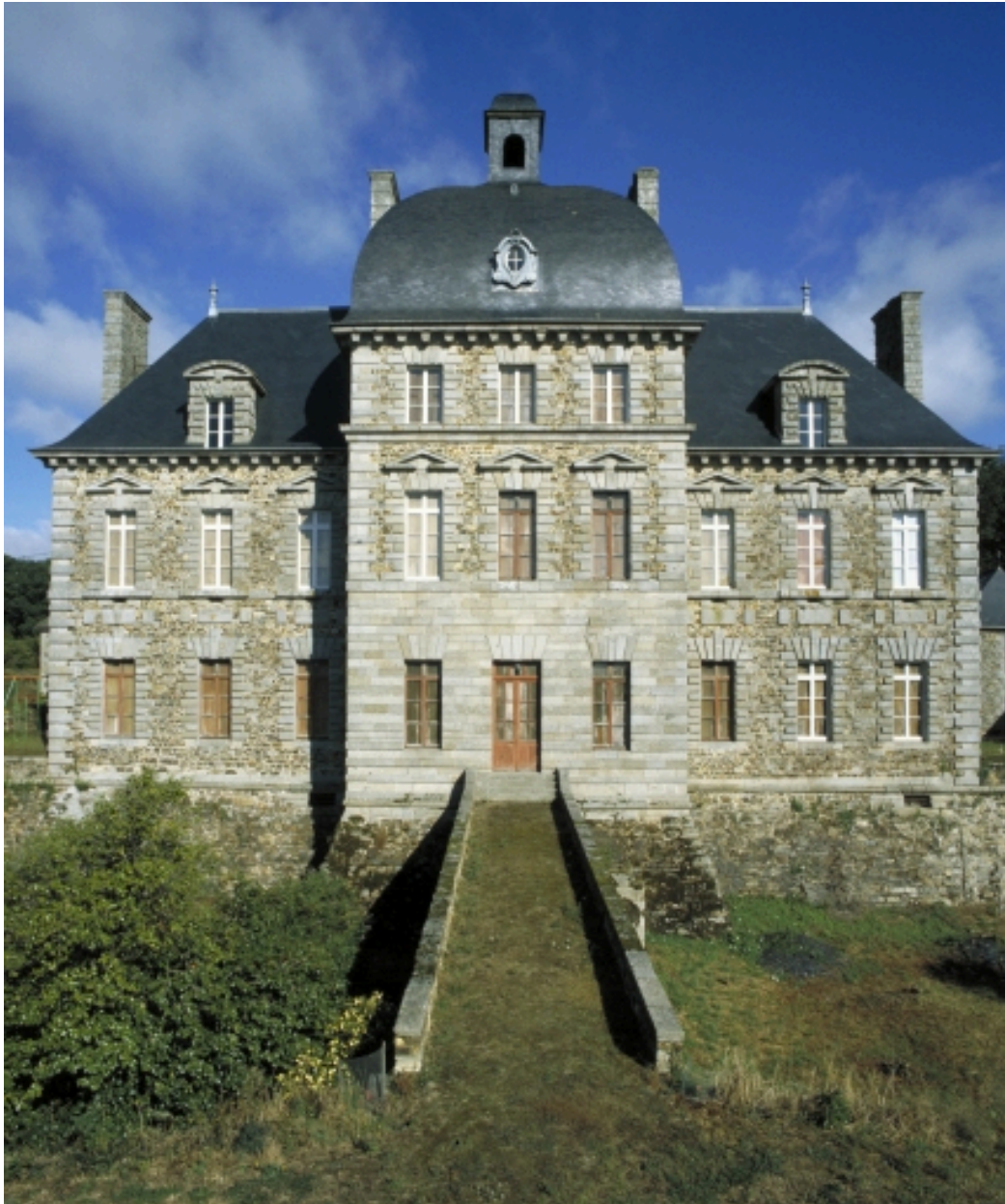
Vue générale sud
