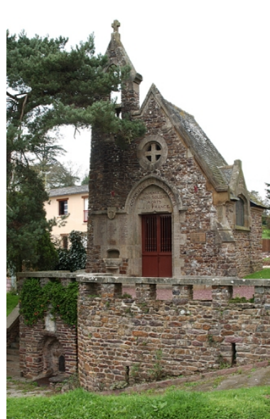
Vue générale sud Phot. Guy Artur, Phot. Norbert Lambart IVR53_20023502698NUCA
