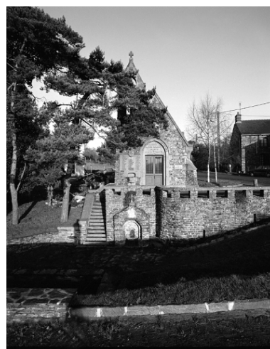
Vue générale sud Phot. Bernard Bègne, Phot. M. Loyon IVR53_19933500042X
