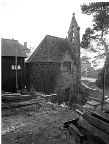
Vue générale ouest Phot. Bernard Bègne, Phot. M. Loyon IVR53_19933500043X
