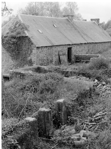
Vue du bief. Phot. Jean-Pierre Ducouret IVR53_19862200286X
