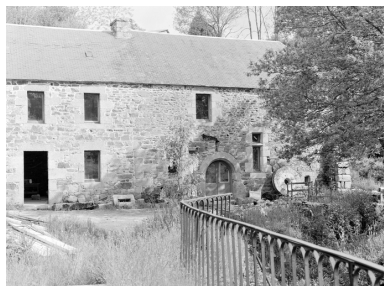
Vue générale sud. Phot. Jean-Pierre Ducouret IVR53_19862200288X
