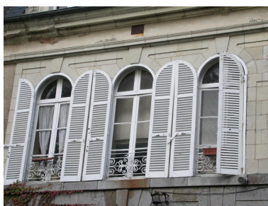
Détail des baies de l'étage de la façade sud Phot. Stéphanie Ménard IVR53_20053519076NUCA
