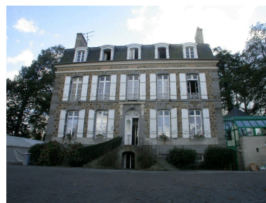
Vue nord Phot. Stéphanie Ménard IVR53_20053519074NUCA
