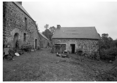
Vue du commun est et du puits Phot. Guy Artur IVR53_19682201414V
