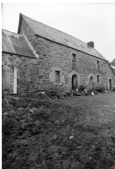
Vue de la face sud Phot. Guy Artur IVR53_19682201413V
