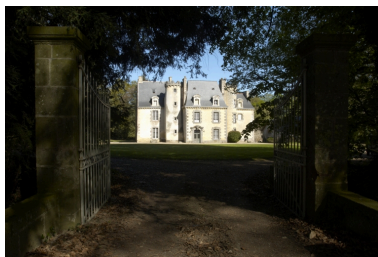
Logis, vue générale de la façade arrière Phot. Norbert Lambart IVR53_20112200498NUCA
