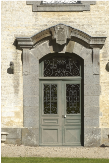
Logis, façade arrière, détail : porte Phot. Norbert Lambart IVR53_20112200504NUCA
