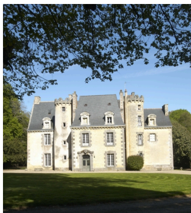
Logis, vue générale de la façade arrière Phot. Norbert Lambart IVR53_20112200505NUCA
