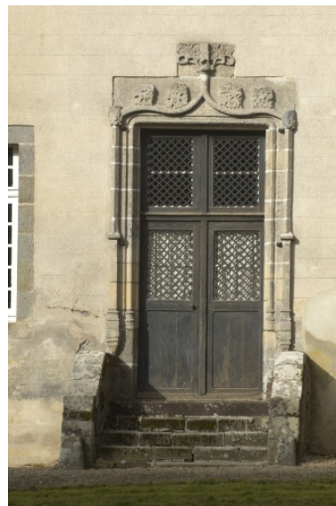
Logis, façade antérieure, détail, porte Phot. Norbert Lambart IVR53_20112200492NUCA
