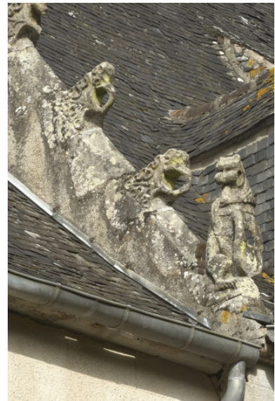
Logis, rampant du pignon, détail Phot. Norbert Lambart IVR53_20112200495NUCA
