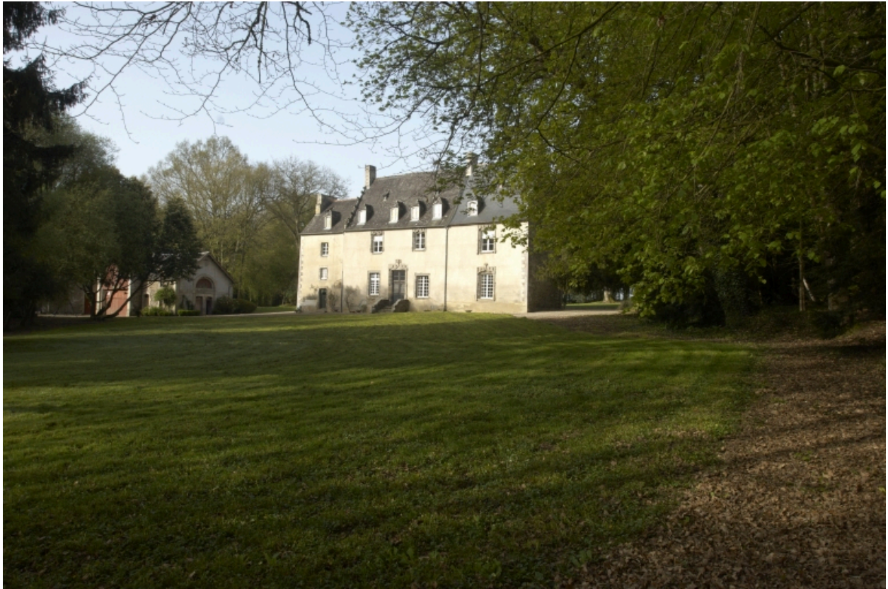
Logis, vue générale
