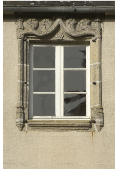
Logis, détail, fenêtre Phot. Norbert Lambart IVR53_20112200480NUCA
