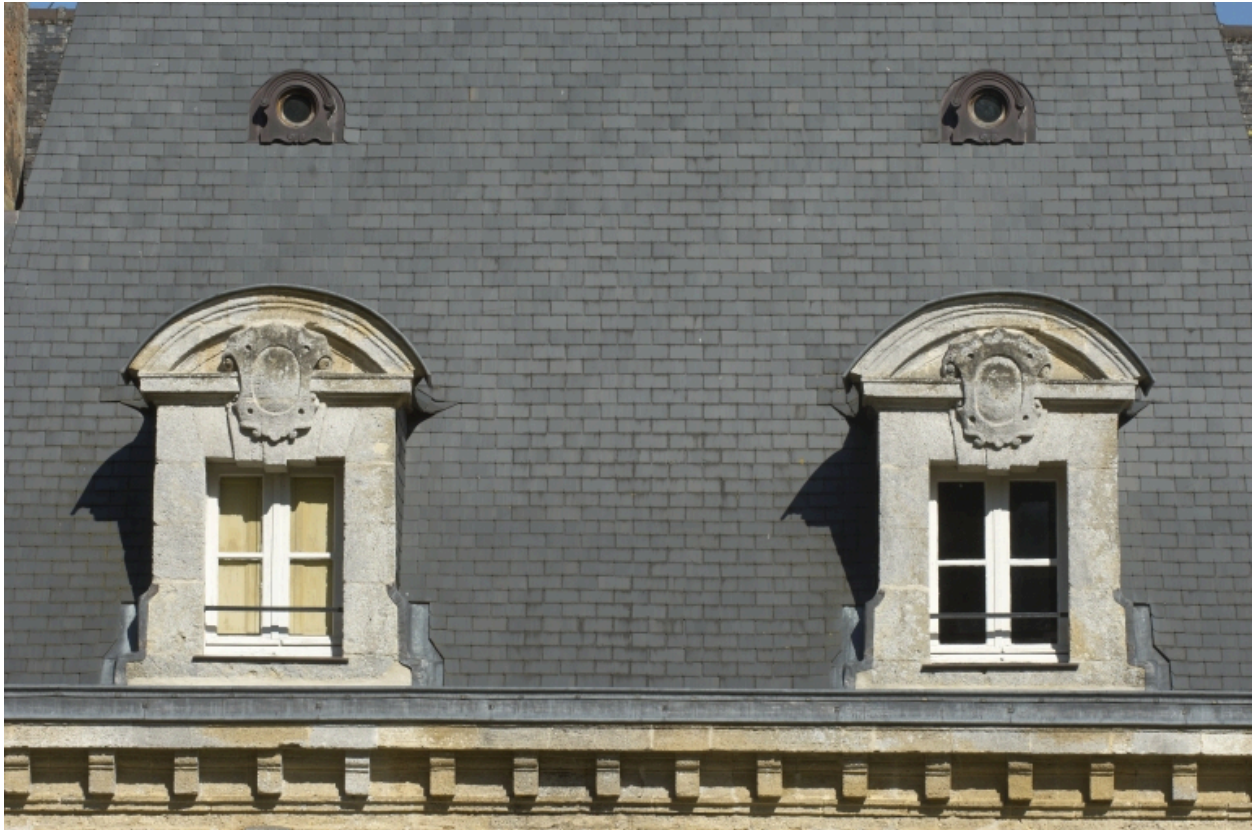
Logis, façade arrière, pavillon central, lucarnes
