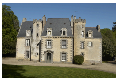
Logis, vue générale de la façade arrière Phot. Norbert Lambart IVR53_20112200497NUCA
