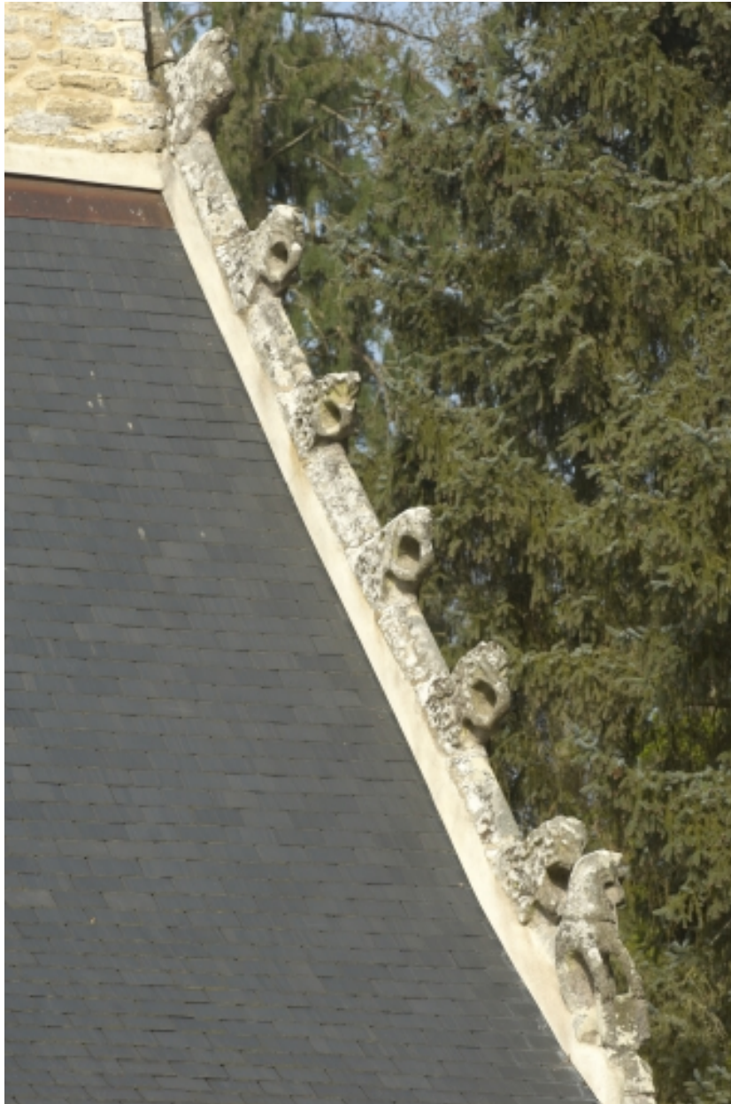
Logis, rampant du pignon, détails
