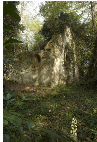
Chapelle, vue générale extérieure Phot. Norbert Lambart IVR53_20112200487NUCA
