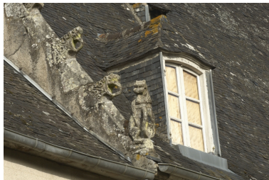
Logis, rampant du pignon, détail : amortissement et crochets sculptés Phot. Norbert Lambart IVR53_20112200479NUCA
