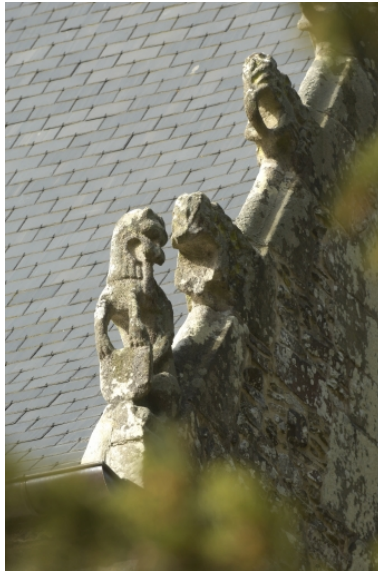
Logis, rampant du pignon, détail Phot. Norbert Lambart IVR53_20112200482NUCA
