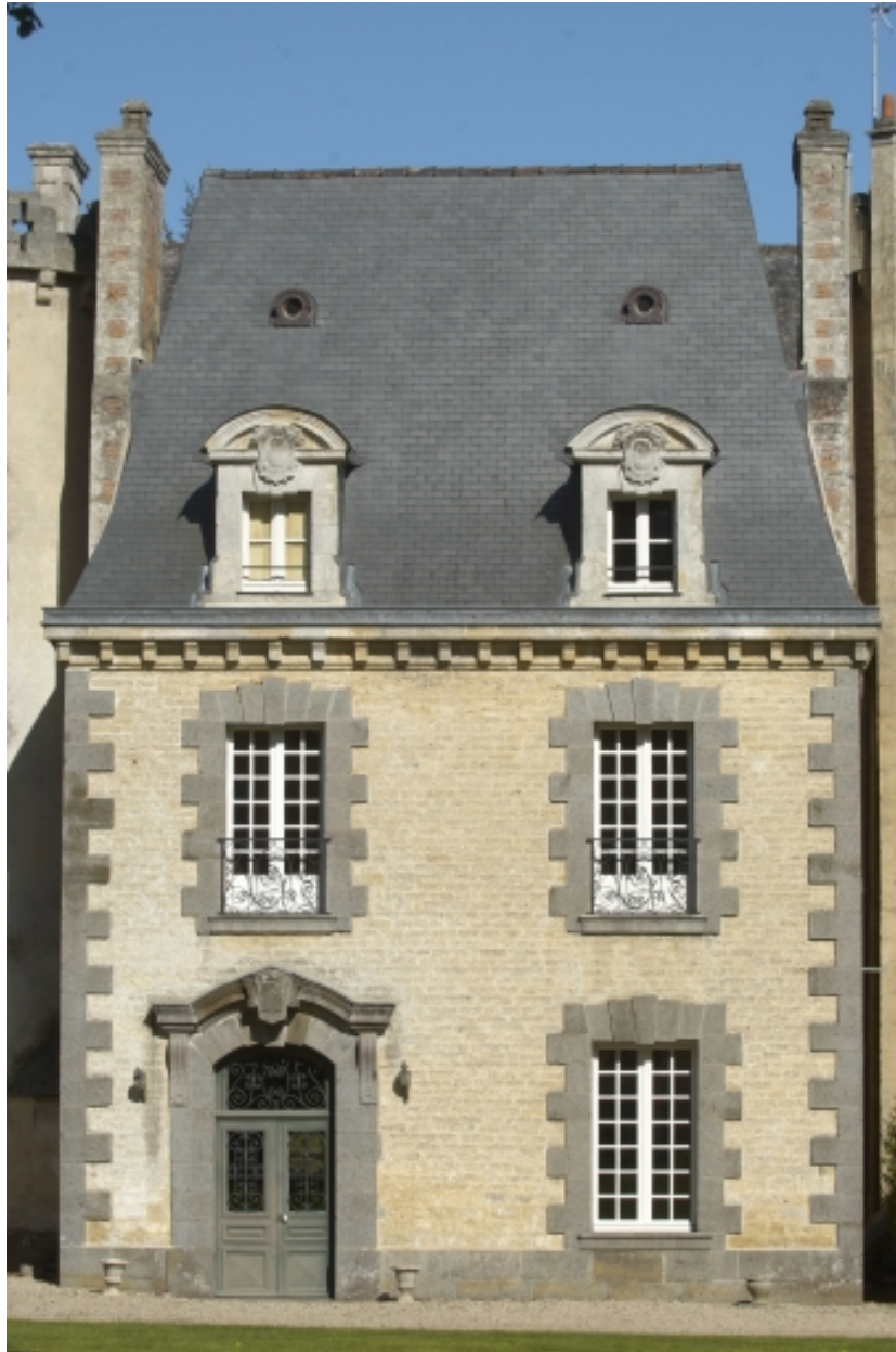
Logis, façade arrière, pavillon central
