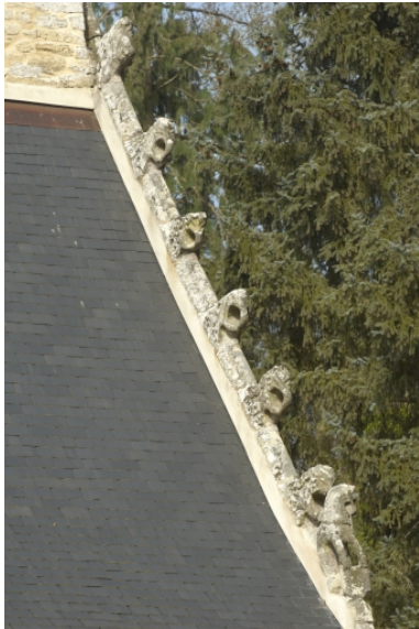
Logis, rampant du pignon, détails Phot. Norbert Lambart IVR53_20112200481NUCA
