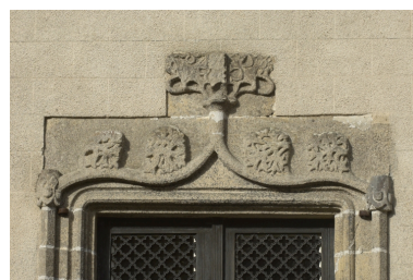
Logis, façade antérieure, porte, détail : décor d'accolade fleuronée Phot. Norbert Lambart IVR53_20112200483NUCA
