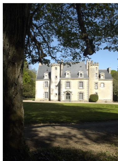
Logis, vue générale de la façade arrière Phot. Norbert Lambart IVR53_20112200499NUCA
