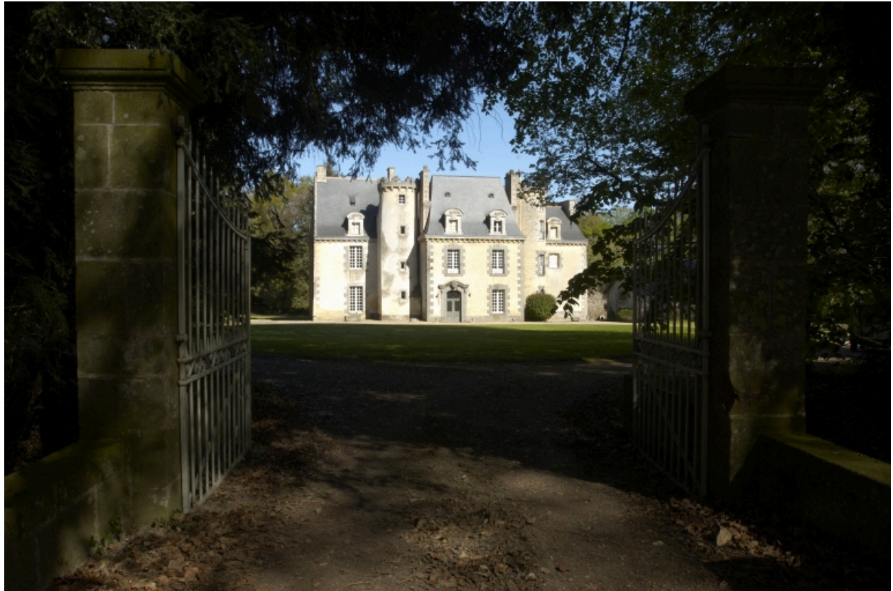
Logis, vue générale de la façade arrière
