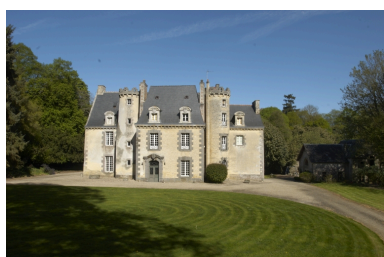
Logis, vue générale de la façade arrière Phot. Norbert Lambart IVR53_20112200496NUCA
