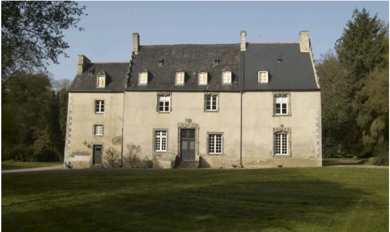
Logis, vue générale
