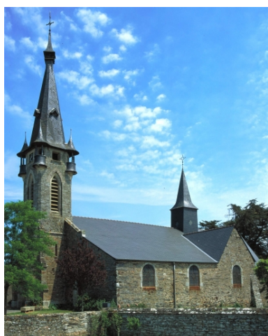
Vue générale sud ouest Phot. Guy Artur, Phot. Norbert Lambart IVR53_20013501833XA
