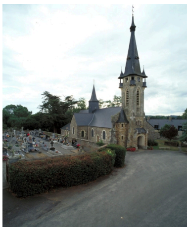
Vue générale nord-ouest Phot. Guy Artur, Phot. Norbert Lambart IVR53_20013501915XA
