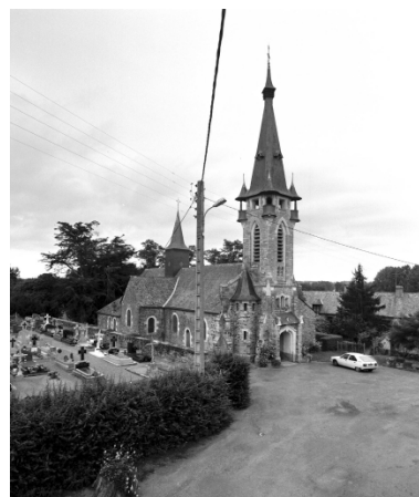
Vue générale nord-ouest Phot. Guy Artur, Phot. Norbert Lambart IVR53_19943501737X
