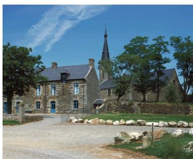
Vue de situation sud est Phot. Guy Artur, Phot. Norbert Lambart IVR53_20013501834XA
