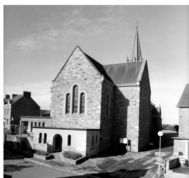
Elévation Est : vue générale Phot. Guy Artur, Phot.
