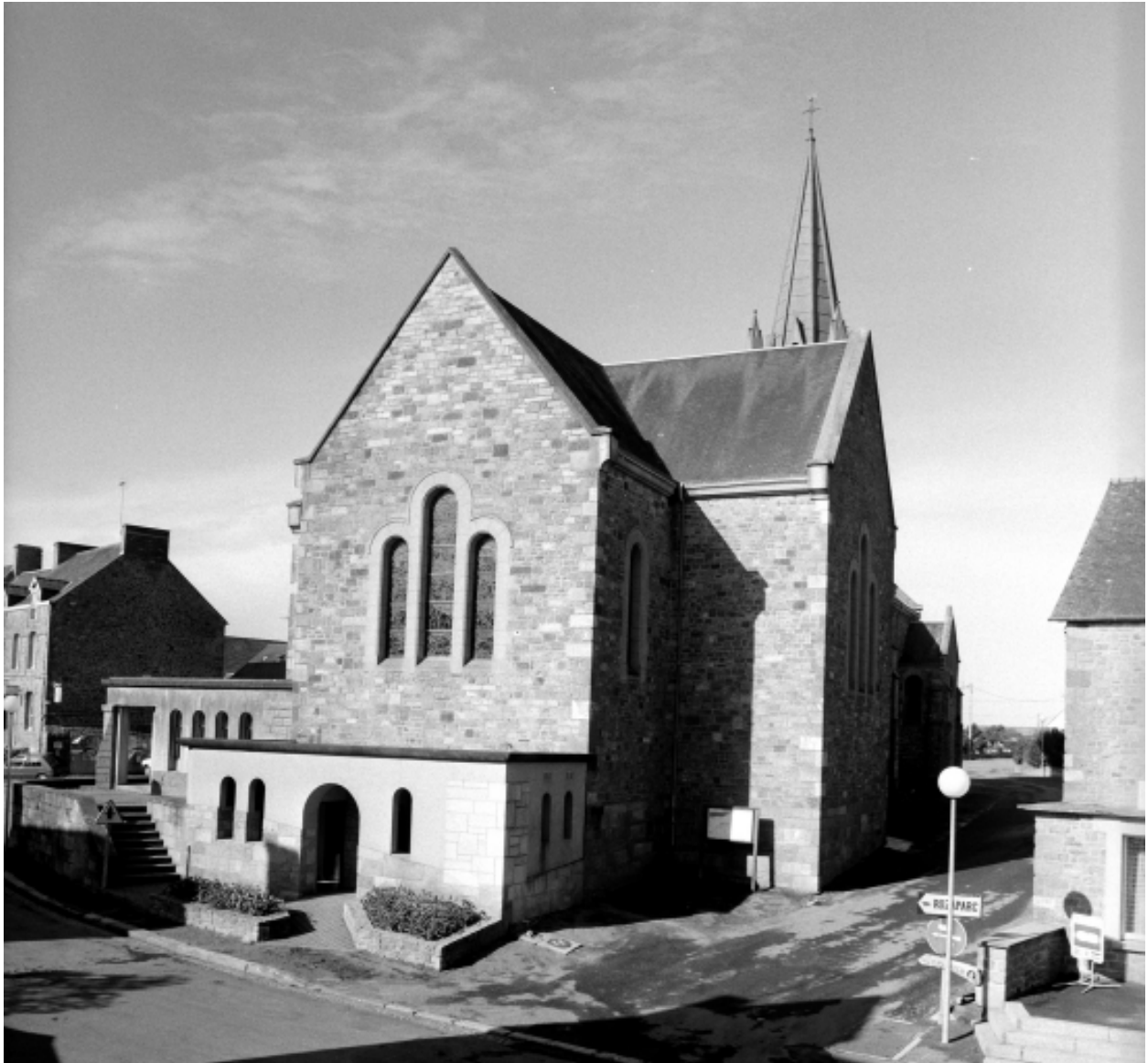
Elévation Est : vue générale
