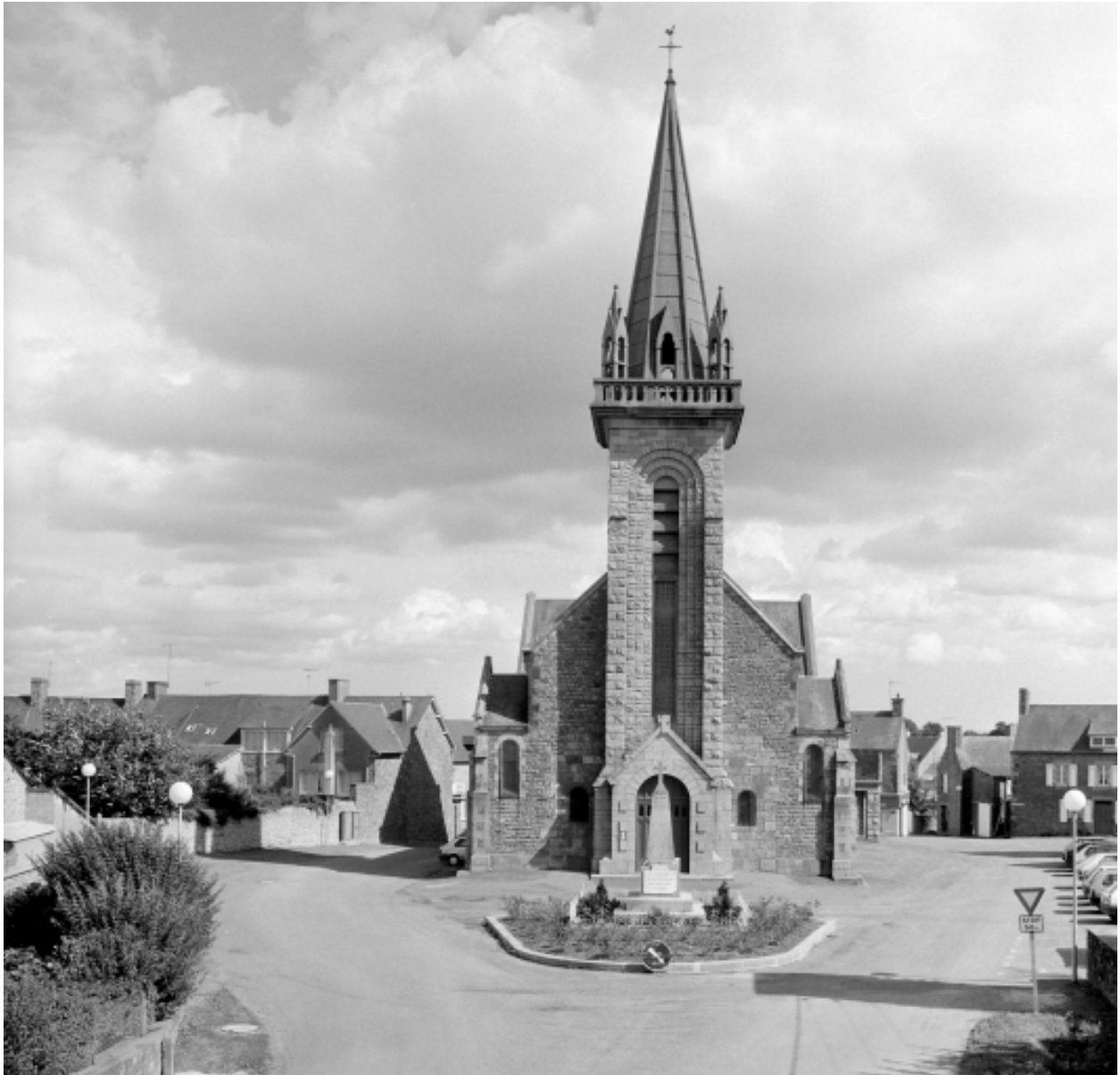
Elévation Ouest : vue générale
