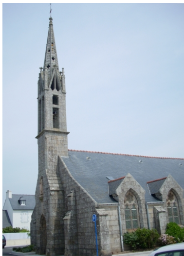
Ile Tudy, église paroissiale Saint- Tudy : vue générale sud-ouest Phot. Gwénaél Fauchille IVR53_20082905888NUCA
