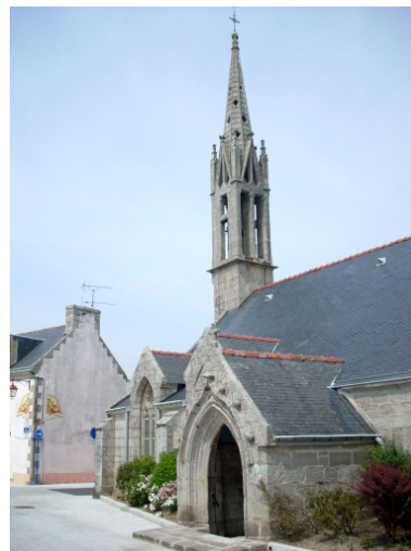
Ile Tudy, église paroissiale Saint- Tudy : vue générale sud-est Phot. Gwénaél Fauchille IVR53_20082905889NUCA
