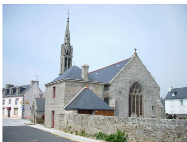
Ile Tudy, église paroissiale Saint- Tudy : vue générale sud-est Phot. Gwénaél Fauchille IVR53_20082905885NUCA
